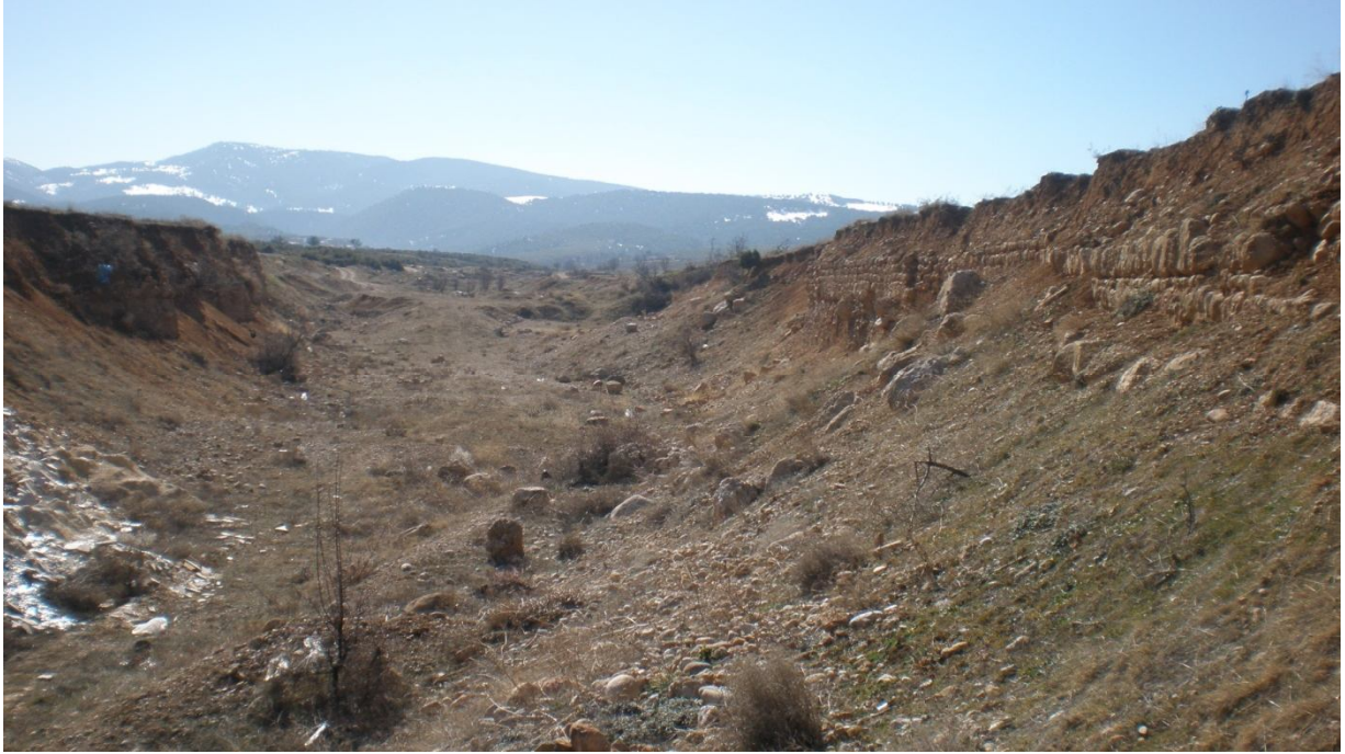
Eber Suyu'nun kurumuş yatağı ve her iki yanda istinat duvarları
