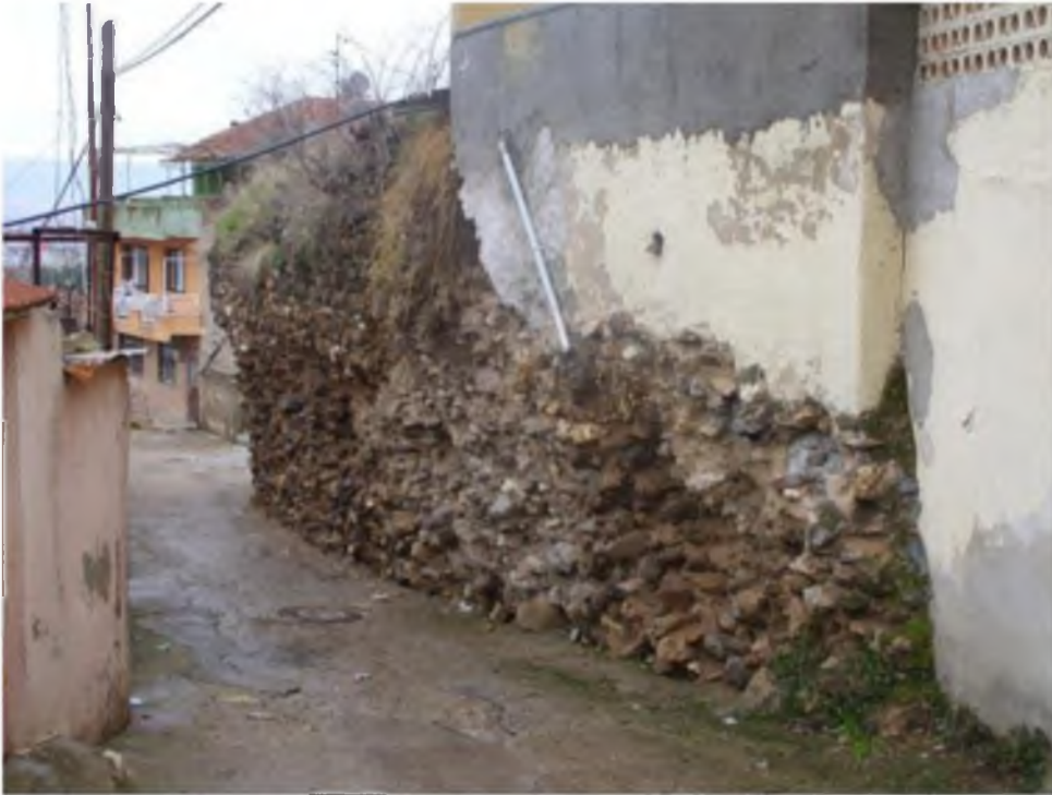
Levha 59. Güney surları, 27 numaralı sur parçası, kuzeybatıdan görünüş.
