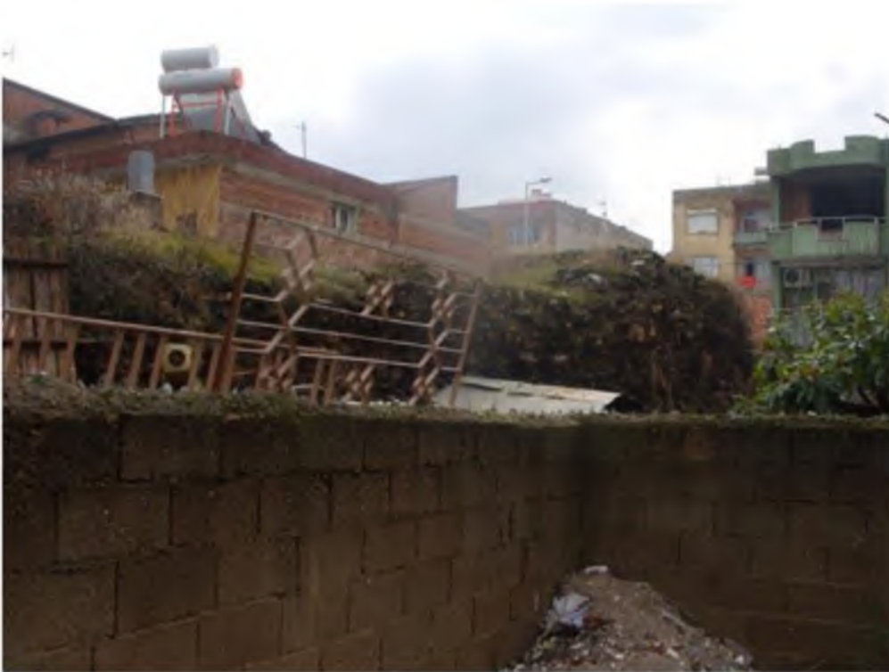
Levha 47. Batı surları, 20 numaralı sur parçası, batıdan görünüş.
