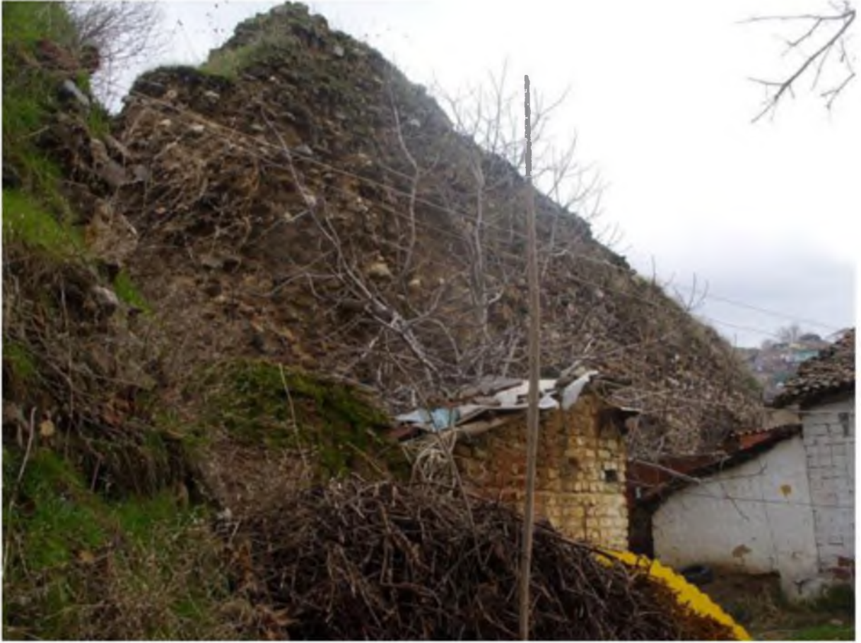
Levha 54. Batı surları, 24 numaralı sur parçası, batıdan görünüş.
