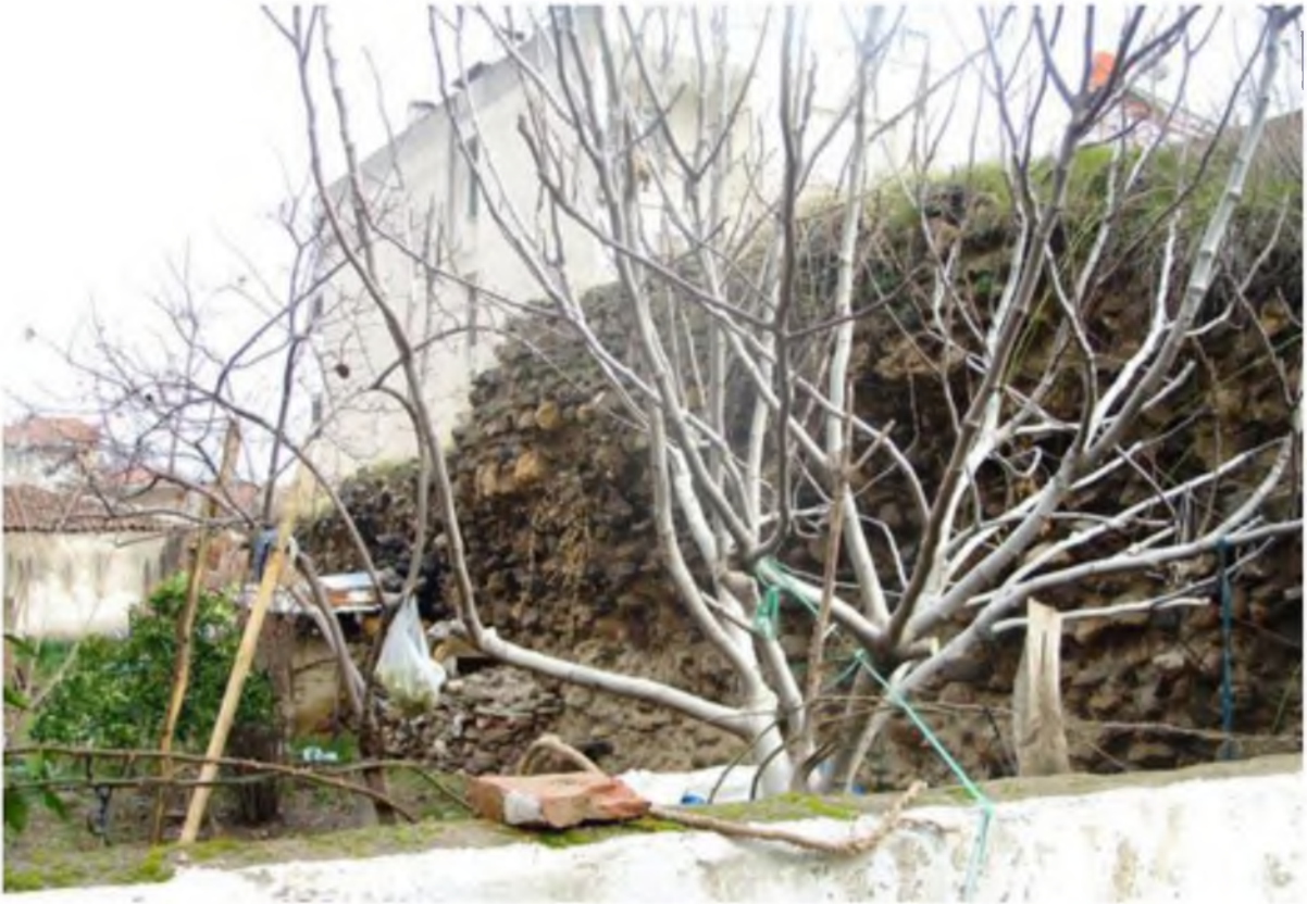
Levha 48. Batı surları, 21 numaralı sur parçası, batıdan görünüş.
