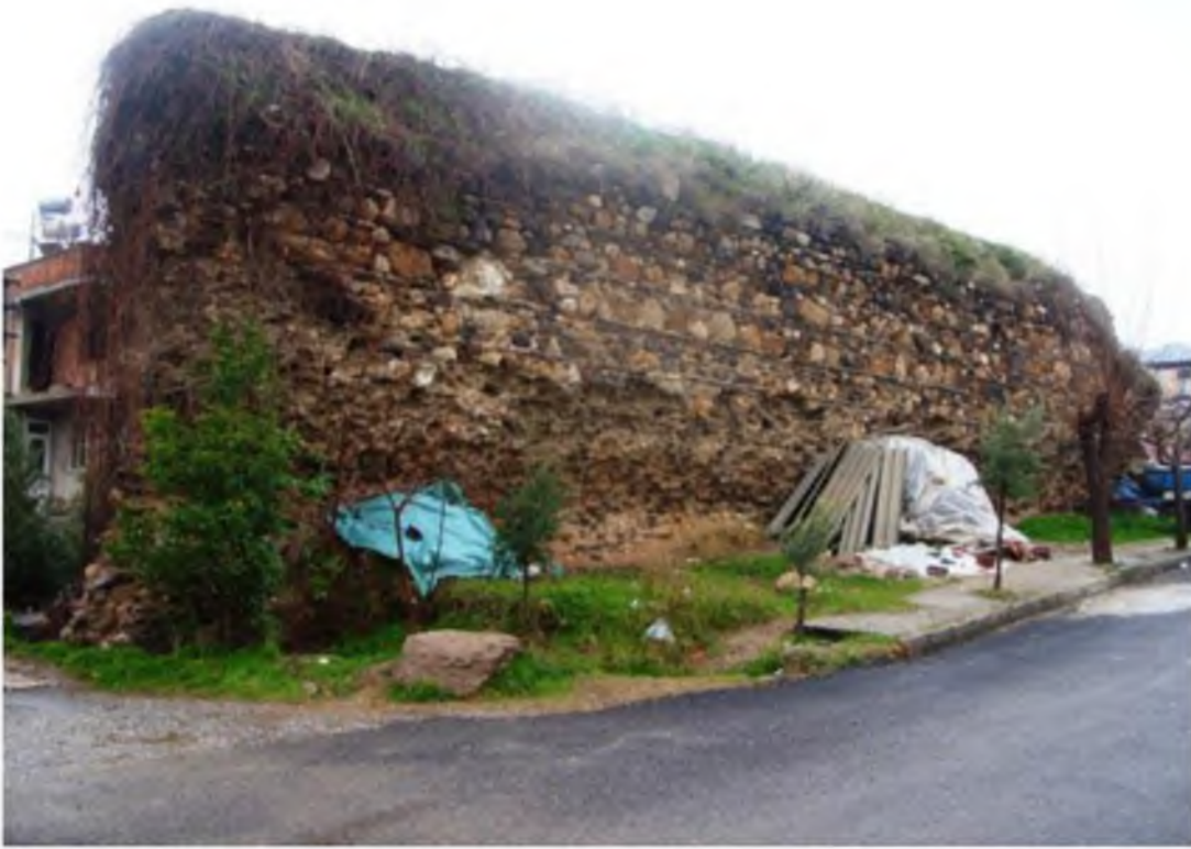
Levha 13. Doğu surları, 3 numaralı sur parçası, batıdan görünüş.
