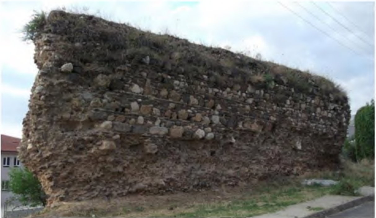
Levha 6. Doğu surları, 1 numaralı sur parçası, batıdan görünüş.
