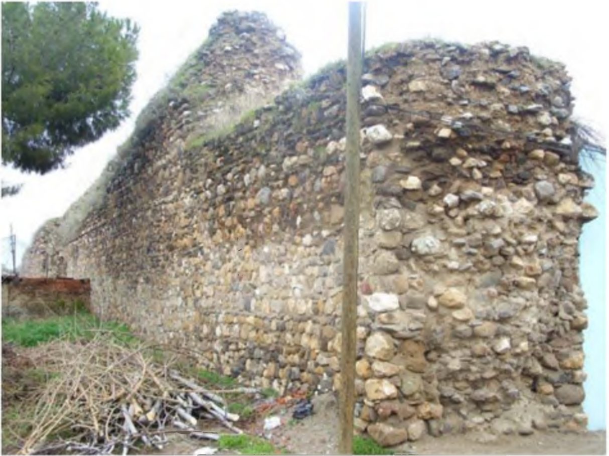
Levha 51. Batı surları, 23 numaralı sur parçası, batıdan görünüş.
