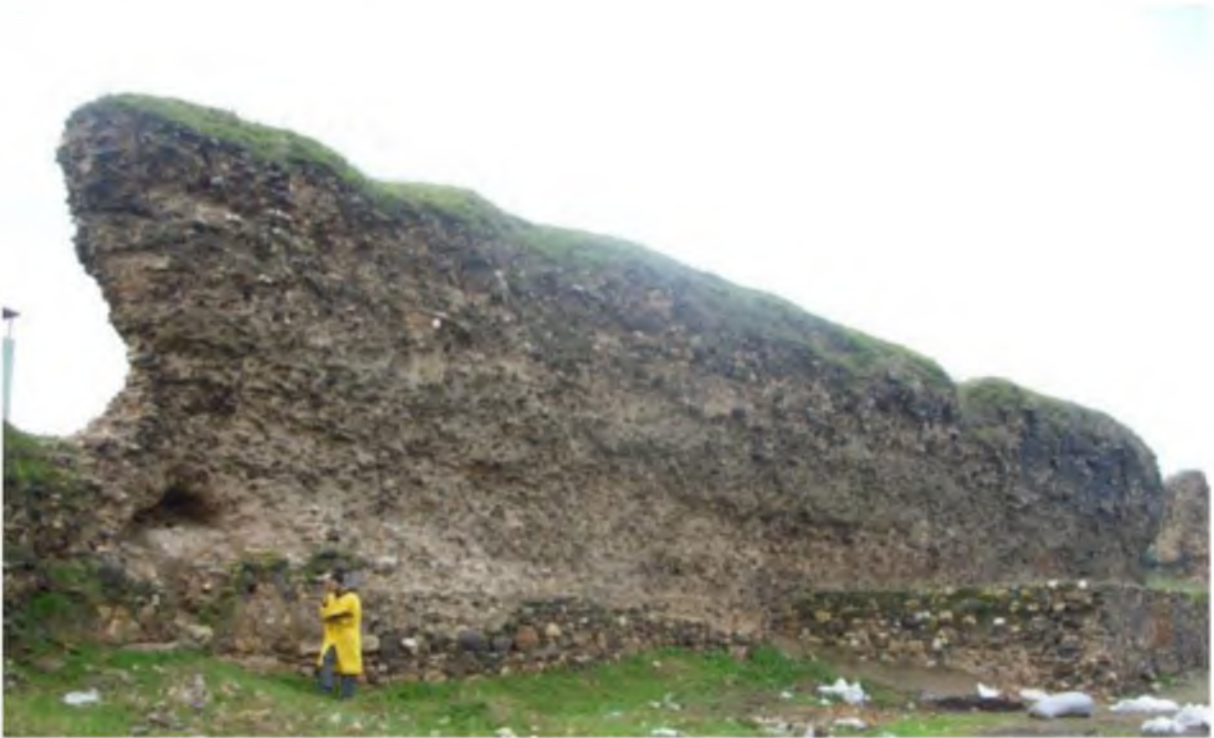
Levha 33. Kuzey surları, 10B, kuzey cephe.
