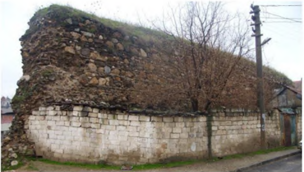
Levha 16. Doğu surları, 4 numaralı sur parçası, batıdan görünüş.
