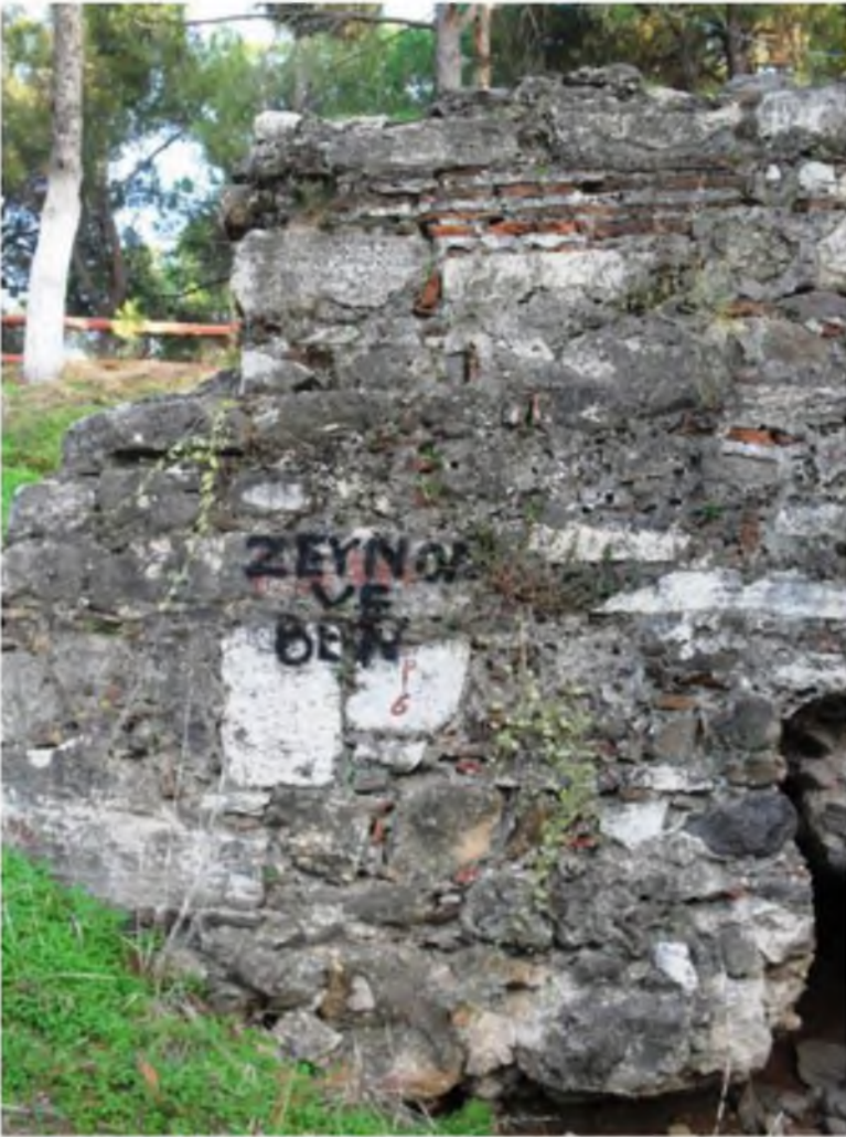
Levha 64. Toptepe'deki Batı Kulesi Kalıntısı, batıdan görünüş, duvar örgüsü.
