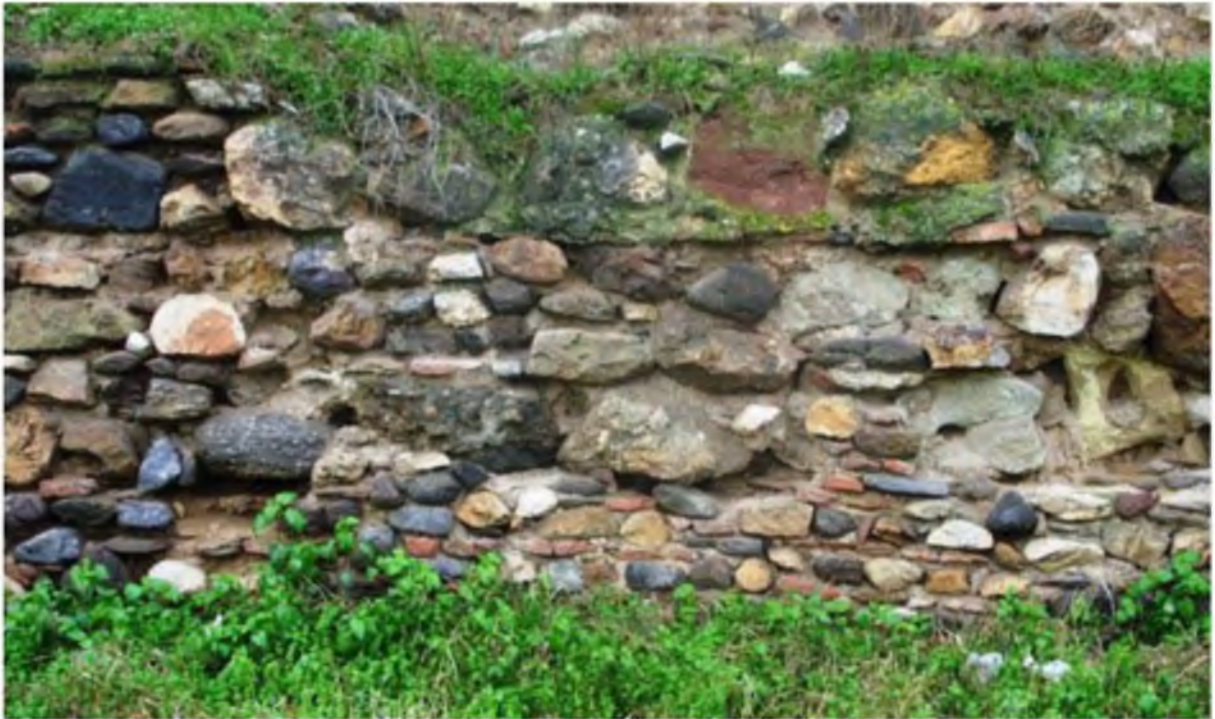
Levha 29. Kuzey surları, 10A numaralı sur parçası (10A), kuzey cephe. alt örgü sıraları, ayrıntı.
