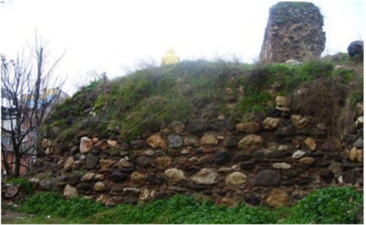
Levha 15. Doğu surları, 3 numaralı sur parçasının güneydoğu köşesinde bulunan kule kalıntısı, kuzey cephe.
