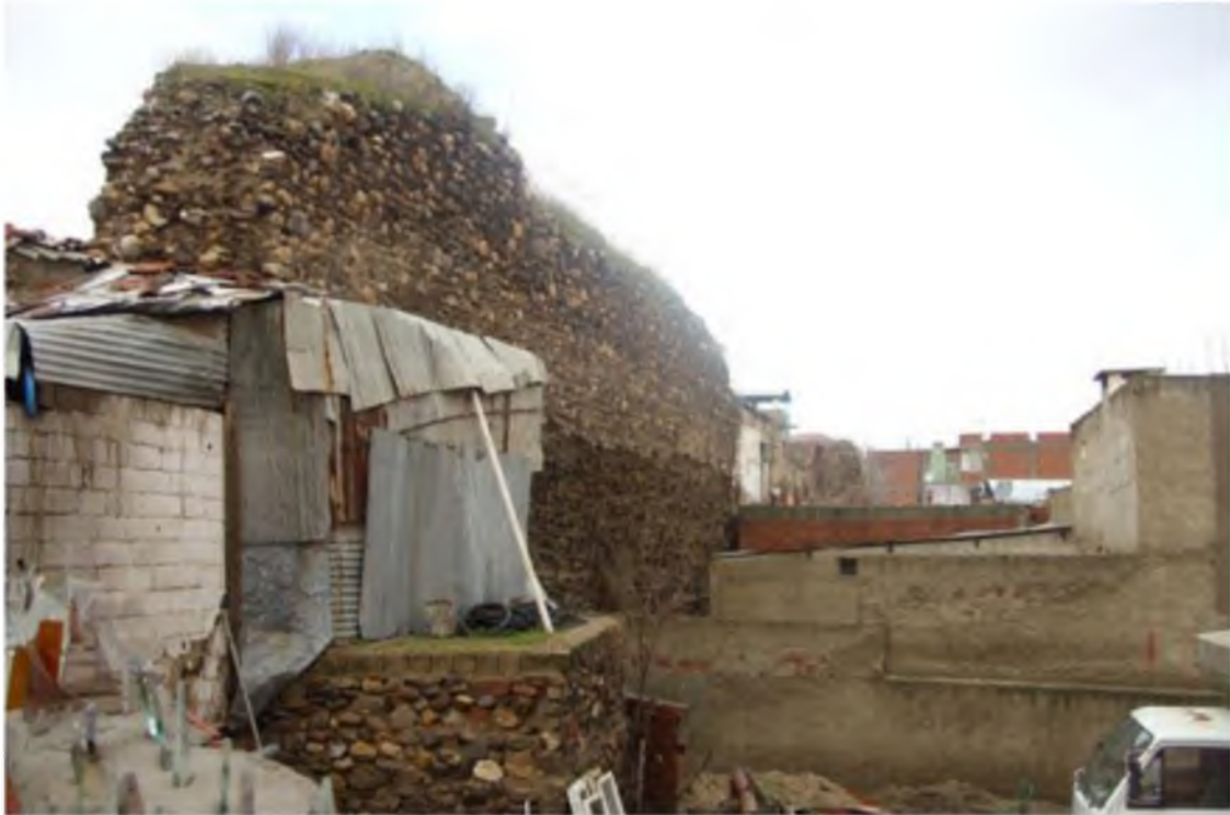
Levha 37. Kuzey surları, 12 numaralı sur parçası, kuzey cephe.
