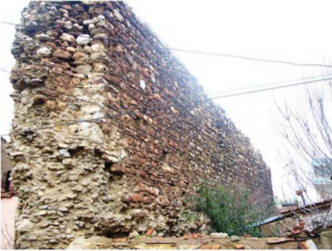
Levha 50. Batı surları, 22 numaralı sur parçası, batıdan görünüş.
