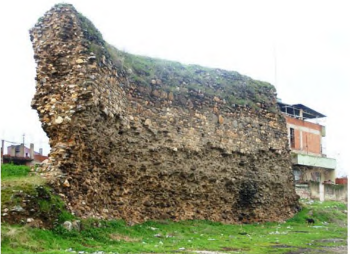
Levha 35. Kuzey surları, 11 numaralı sur parçası, kuzey cephe.
