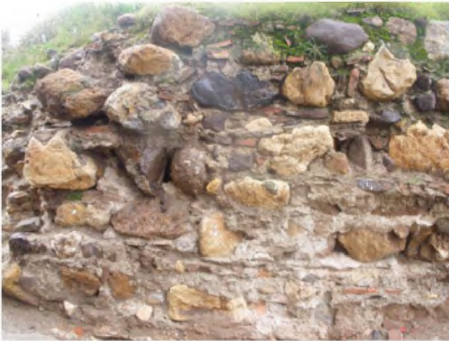
Levha 27. Kuzey surları, kuzeydoğu köşedeki kule, kuzeyden görünüş, ayrıntı.
