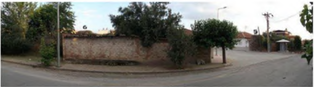
Levha 18. Doğu surları, 5 ve 6 numaralı sur parçaları, doğudan görünüş.
