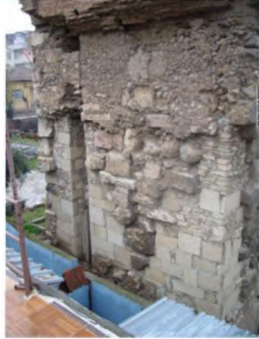
Levha 79. Kuzeydoğu payesi, doğu yüzü.
