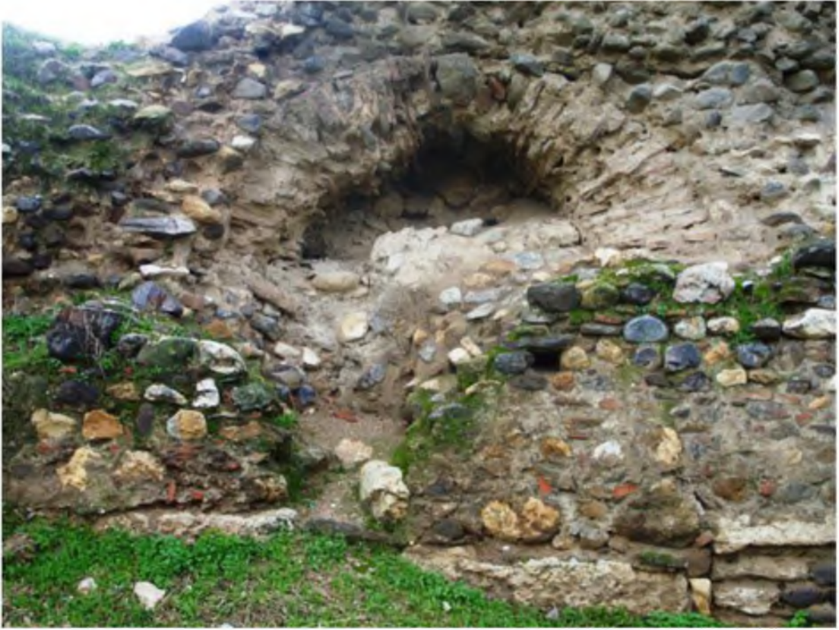
Levha 32. Kuzey surları, 10B, 2 numaralı tali kapı, kuzey cephe.
