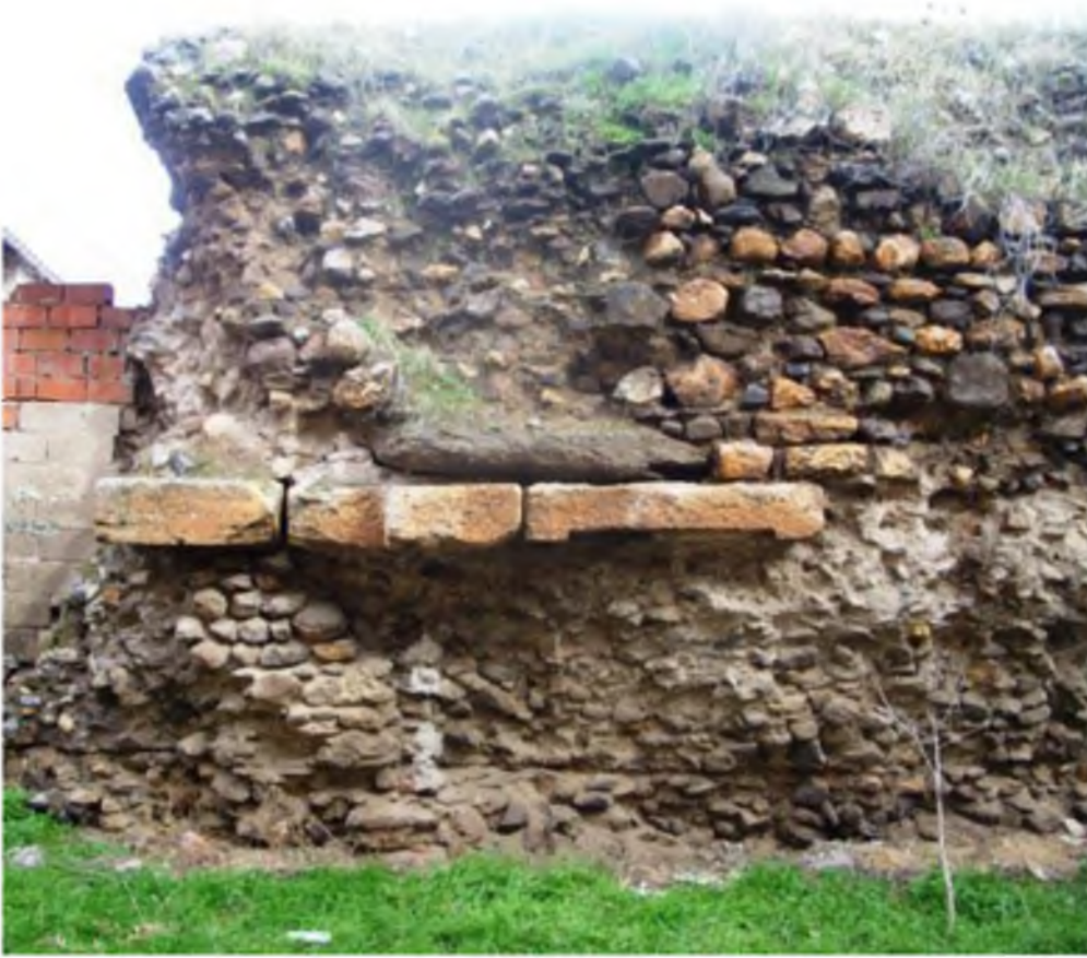
Levha 42. Kuzey surları, 15 numaralı sur parçası, devşirme bloklar, güneyden görüntü.
