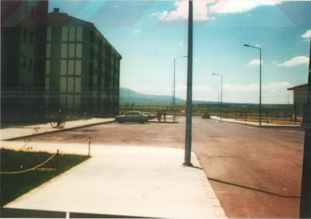
Şekil 3.65. Başbakanlık Toplu Konut Bölgesine ait otopark alanlarından bir görünüm.
