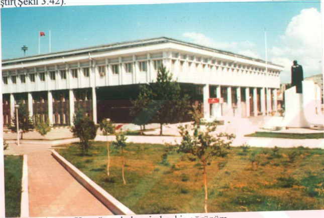
Şekil 3.42. Kars Hükümet Konağı ve bahçesinden bir görünüm
