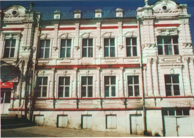
Şekil 3.35. Kars Sağlık Müdürlüğü Binasından bir görünüm
