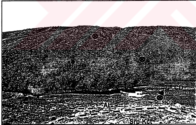
Foto 2.2. Yakakayı gölet yeri sol sahilden sağ sahile batı yöne doğru genel bir bakış (ÇD: Çay deresi, Al: alüvyon, SK: sondaj kuyusu, Srp: serpantinit, Rdy: radyolarit, Kçt: kireçtaşı)
