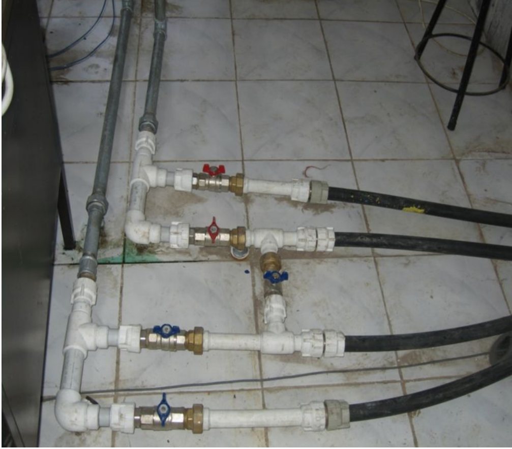
ŞEKİL 3.4. Isı deęiřtiricilerinin kollektör üzerindeki diziliřini gsteren resim
