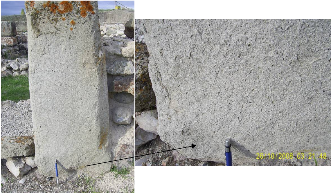
Şekil 10.9 Mabet sarayındaki kapı girişlerinde kullanılan Deniz Köyü yakın civarında Mahkemegeđiği Tepe bölgesinde yer alan dasit yönelimli hornblend andezit
