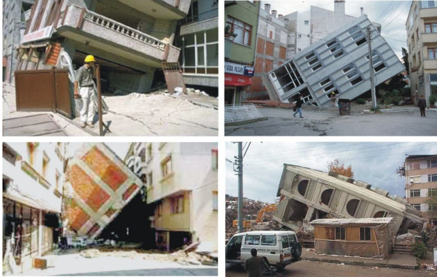
Şekil 1.1 17 Ağustos 1999 İzmit depreminde Adapazarı'nda sıvılaşmaya bağlı olarak meydana gelen hasarlar
