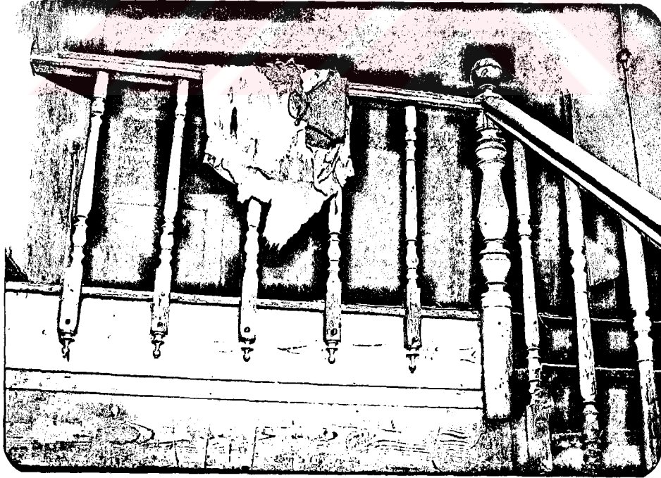
Fotoğraf 3.87. Korkuluk dönüşlerinde özel korkuluk ayakları
