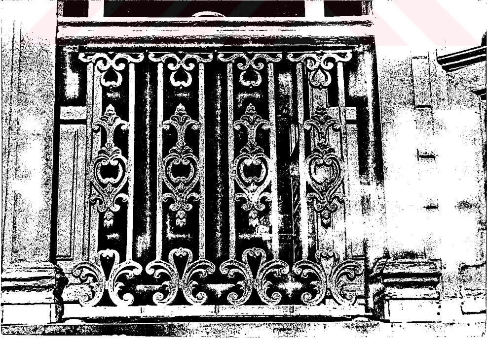
Fotoğraf 3.36. Dış merdiven korkuluk örneđi.
