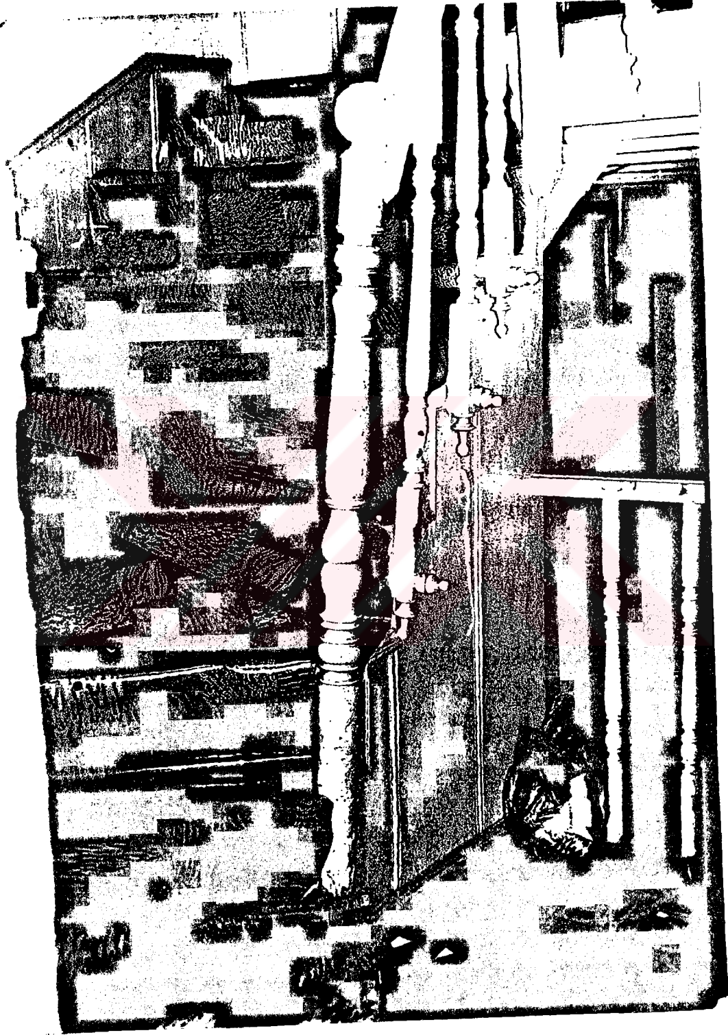
Fotoğraf 3.8. Karma basamaklı giriş aksının bir tarafında düzenlenmiş bodrum + 1 katlı konut merdiveni
