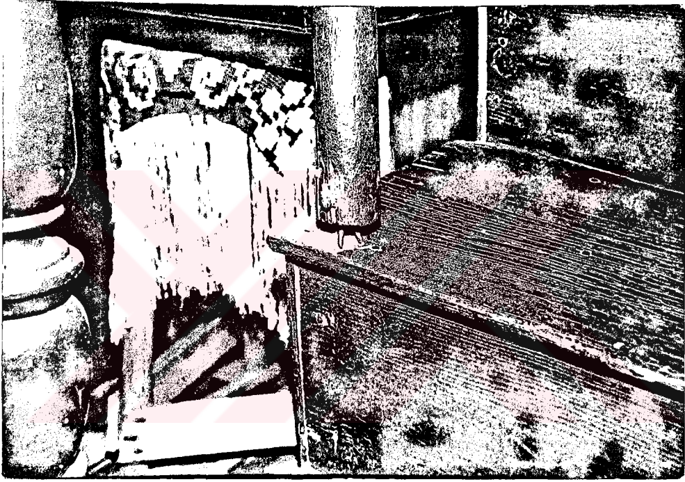
Fotoğraf 3.97. Korkuluk ayağının merdivene tespit detayı örneđi.
