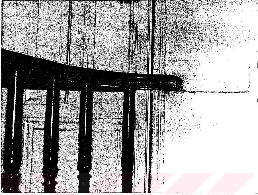
Fotoğraf 3.90. K peşte duvar birleřim detayı  rneđi.
