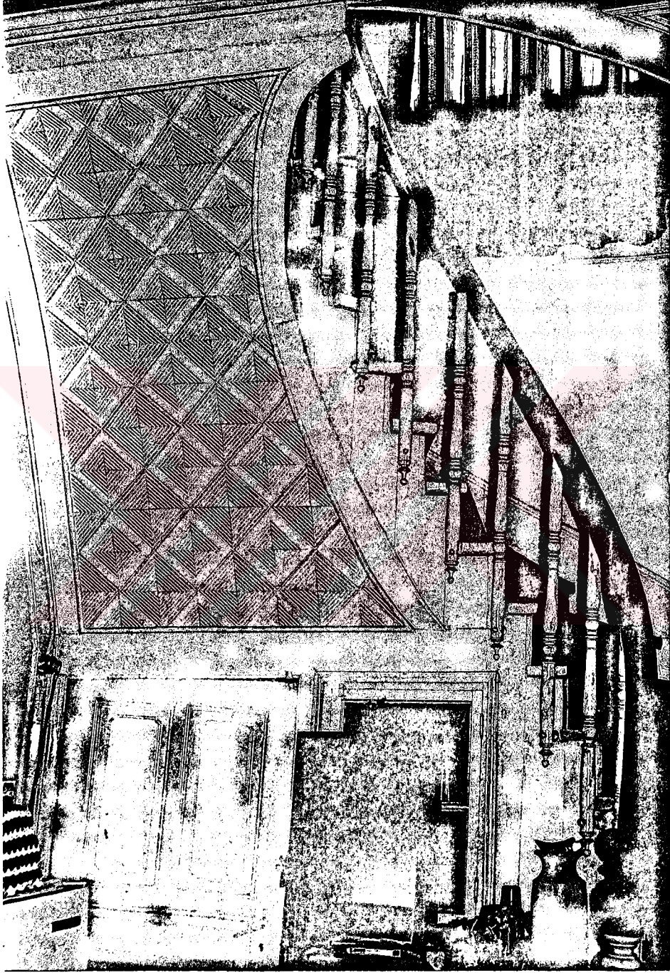
Fotoğraf 3.54. İç merdivenlerde merdiven alt yüzü örneği.
