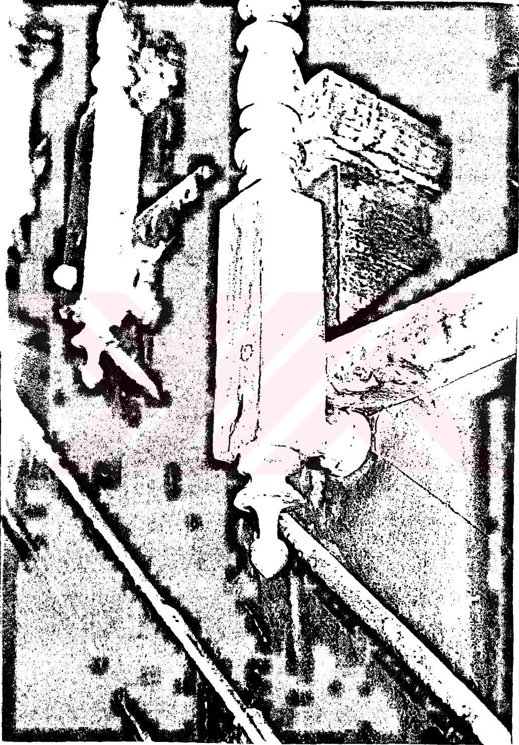
Fotoğraf 3.95. Korkuluk ayağının merdivene tespit detayı örneği.
