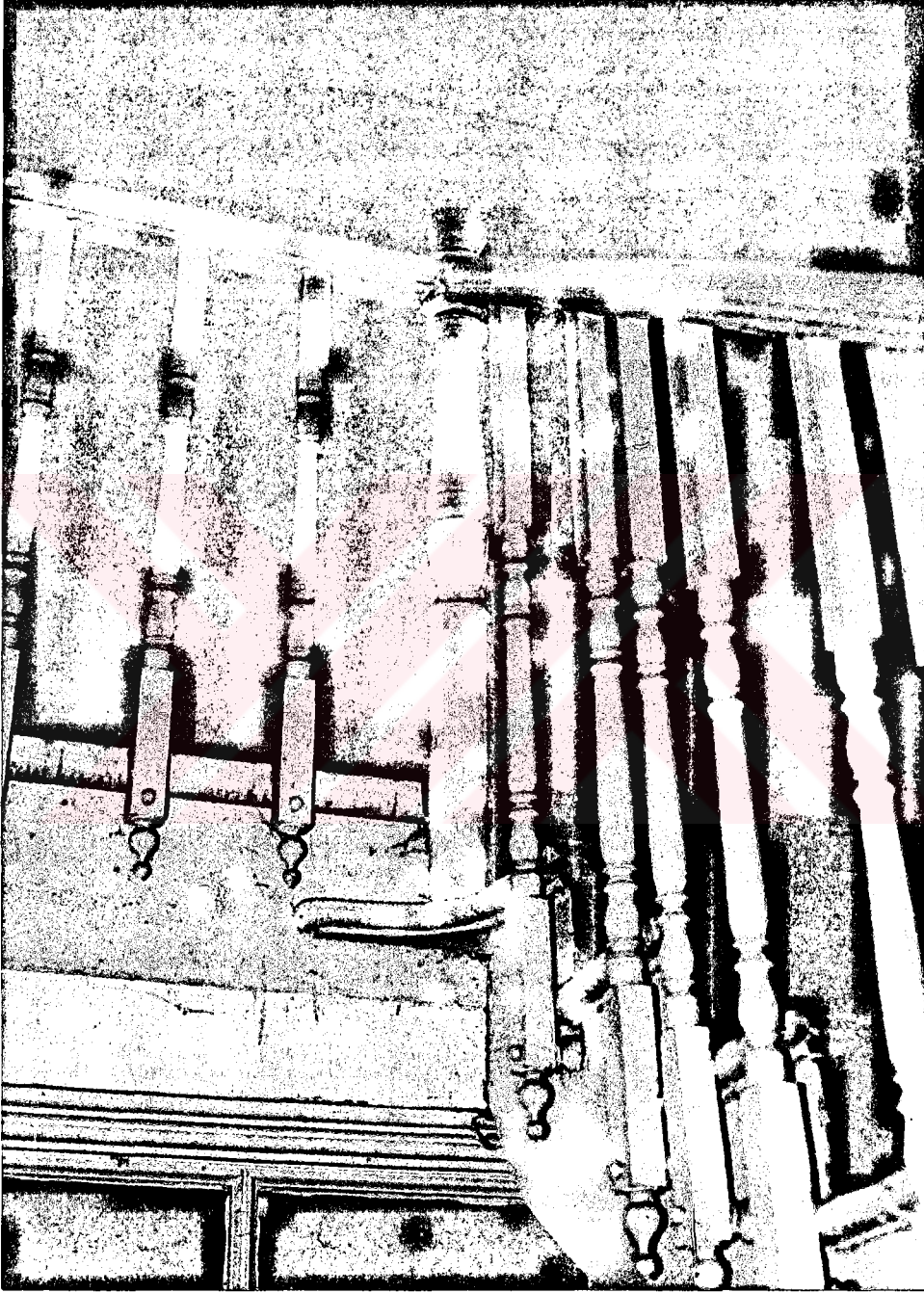
Fotoğraf 3.89. Korkuluk dönüşlerinde özel korkuluk ayakları
