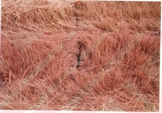
Resim 2. T1 no'lu profilde oluşan vüzey catlakların görünümü
