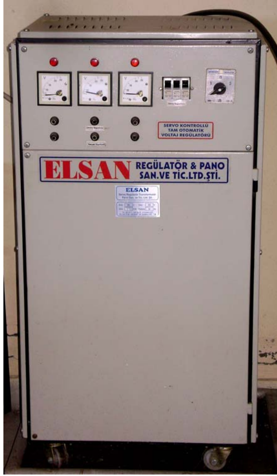
Şekil 3.7. Servo elektronik trifaze voltaj regülatörü
