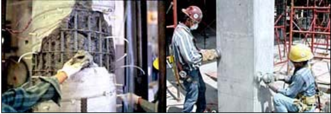
Şekil 1.14. FRP uygulaması öncesi yapılan hazırlıklar
