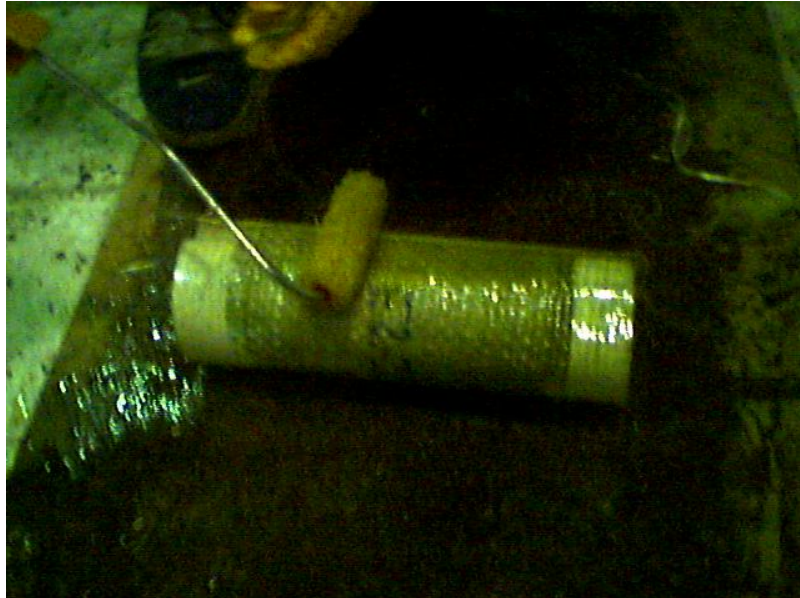
Şekil 3.9. GFRP sargılı beton yüzeyine reçine tatbiki
