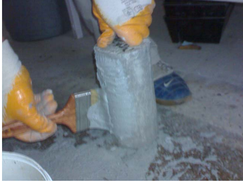
Şekil 3.10. Epoksi esashlı malzemenin beton yüzeyine tatbiki
