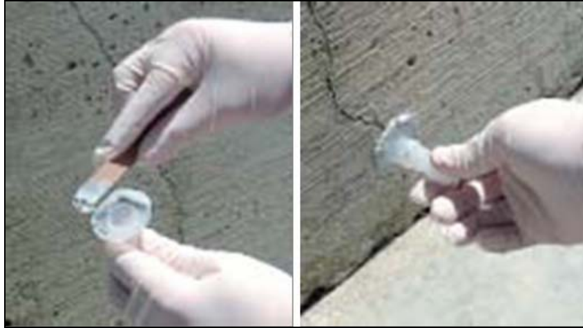
Şekil 1.6. Uygulama elemanına yapıştırıcı tatbiki ve yerine yerleştirilmesi
