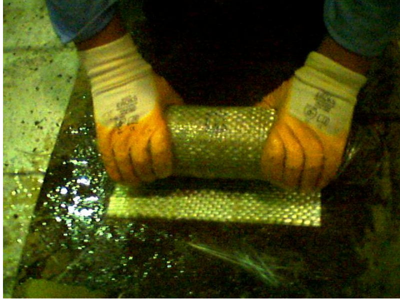
Şekil 3.8. GFRP'nin beton yüzeyine sarılması
