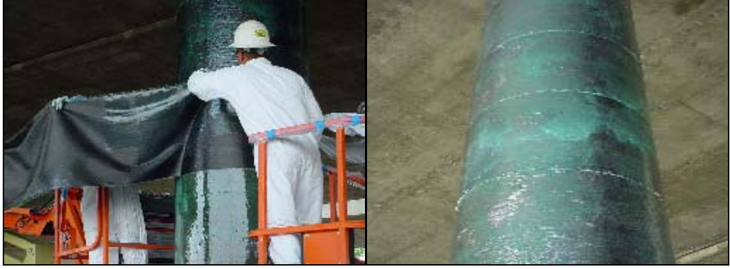
Şekil 1.15. FRP uygulaması yapılan bir kolon
