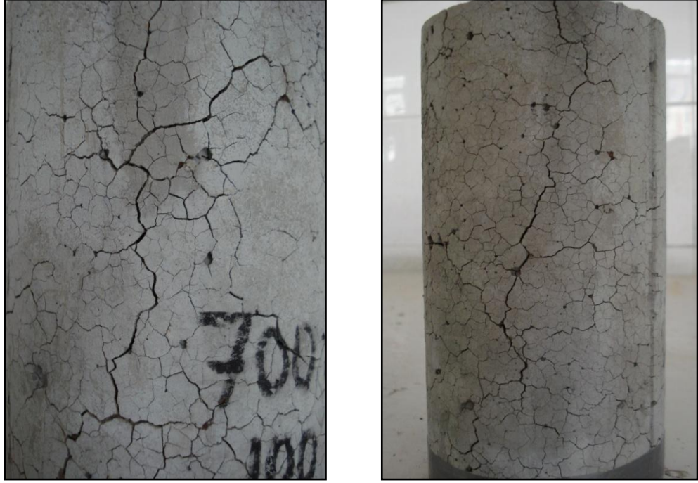
Şekil 4.28. 700°C sonrası perlitli numunelerdeki çatlakların görüntüsü
