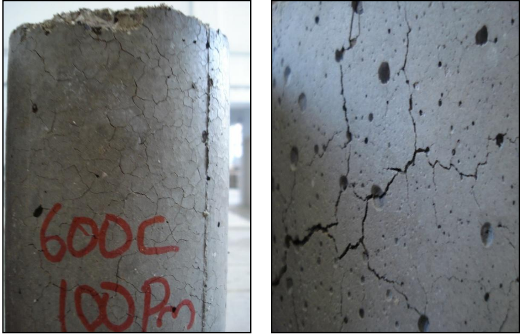
Şekil 4.24. 600°C sonrası pomzalı numunelerdeki çatlakların görüntüsü
