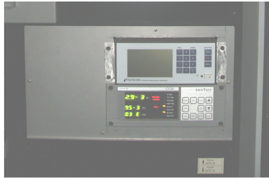
Şekil 2.7. DC reaktif manyetik sıçratma sistemi kontrol ünitesi
