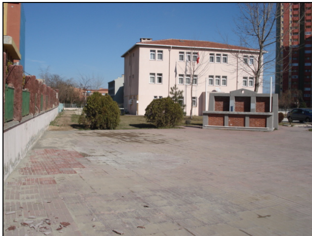
Şekil 4.13. 7 Nolu Sağlık Ocağının bahçesinden bir görünüm
