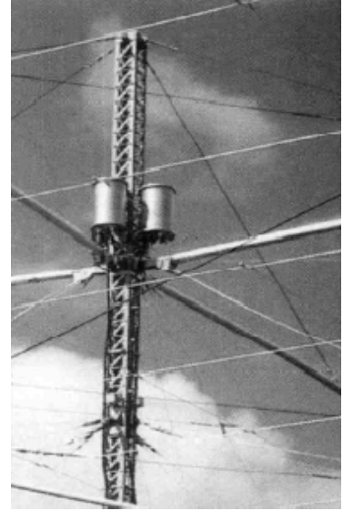
Resim 5.1 Çapraz Dipol Anten
