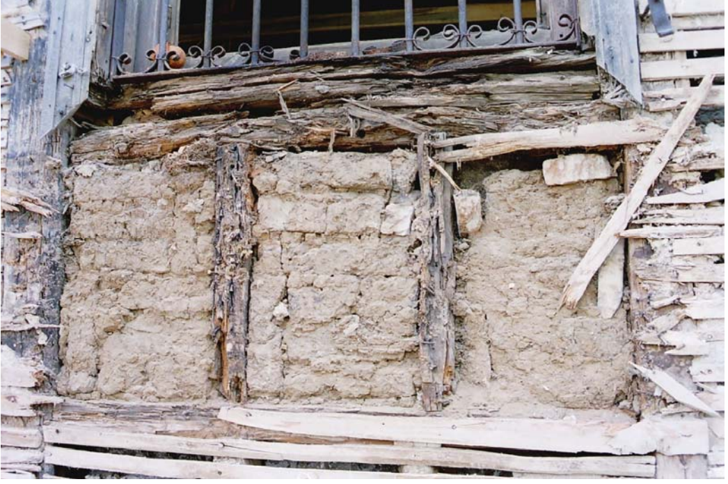
Resim 3.2 Ahşap İskelet Sistemin Dolgu Malzemeleriyle Doldurulması
