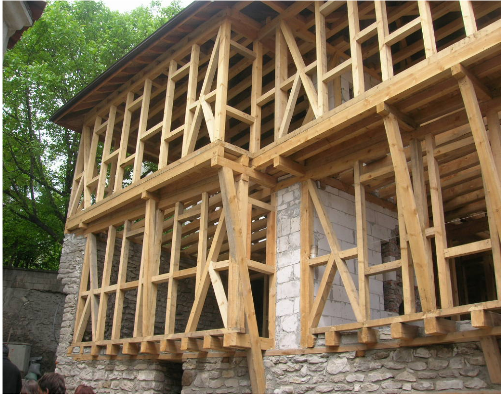
Resim 3.1 Ahşap İskelet Sistem Taşıyıcı Kısımlar
