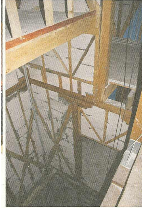
Resim 3.3 Ahşap İskelet Sistemin Dolgu Malzemeleriyle Doldurulması
