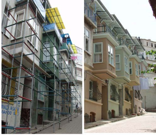
Resim 6.3. Evlerin Restorasyon Öncesi ve Sonrası
