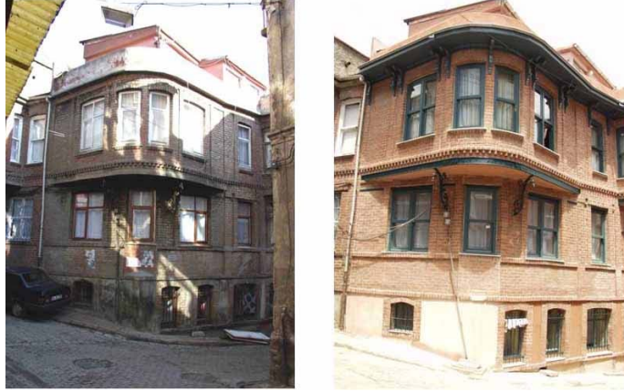
Resim 6.4. Evlerin Restorasyon Öncesi ve Sonrası
