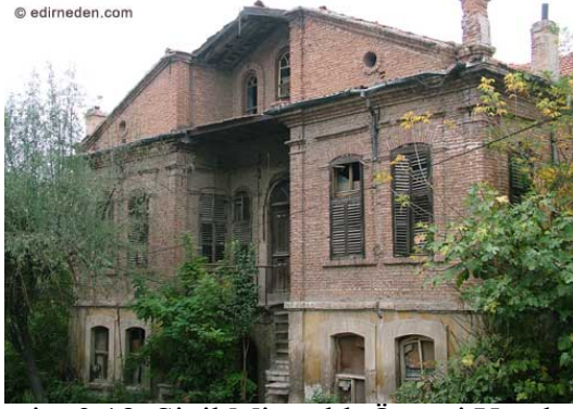
Resim 3.18. Sivil Mimarlık Örneği Yapılar
