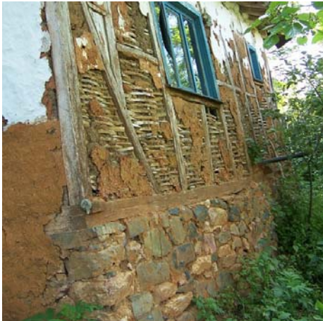
Resim 3.4. Ahşap iskelet bir yapıdan su basman detayı
