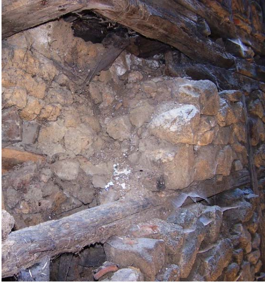
Resim 3.22. Taş - kerpiç tabakalı duvar
