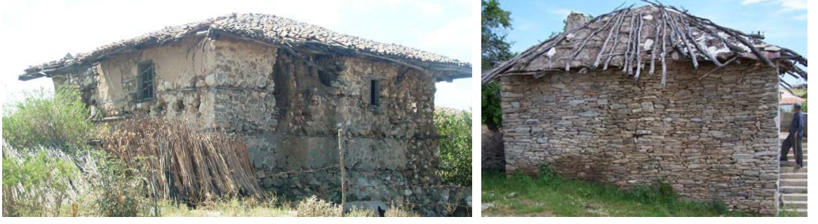
Resim 3.2. Taş yığma yapı örnekleri
