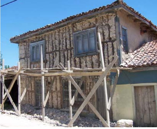
Resim 3.15. Ahşap iskelet arası kireç harçlı taş dolgu
