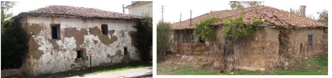
Resim 3.3. Kerpiç yığma yapı örnekleri
