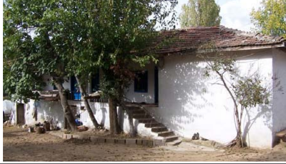
Resim 1. Yapının ön cephesi
