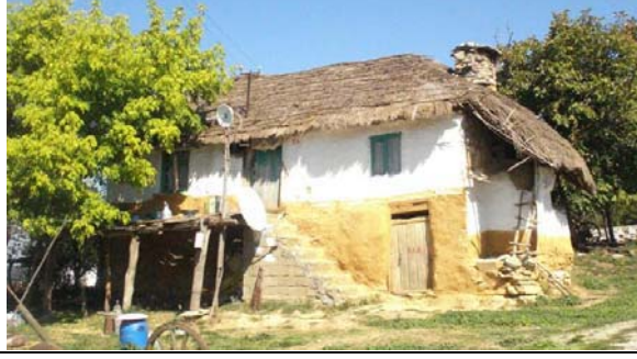
Resim 1. Yapının ön cephesi
