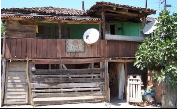
Resim 1. Yapının ön cephe görünüşü
