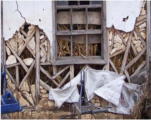
Resim 3.14. Ahşap iskelet arası harçsız taş dolgu
