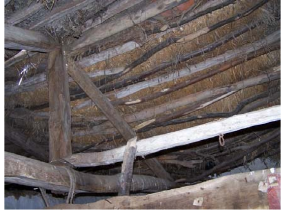
Resim 36. Kiremit altında ağaç dalı üzeri çavdar sapı kaplama
