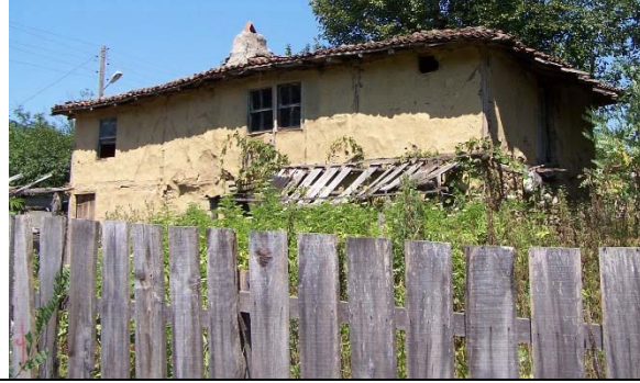
Resim 1. Yapının ön cephe görünüşü
