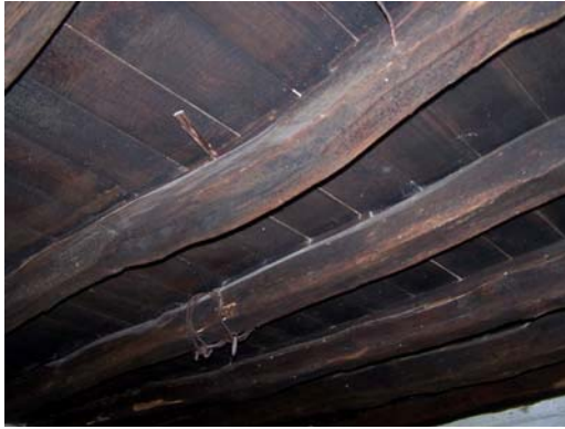
Resim 3.25. Kirişleme üzeri ahşap kaplamalı tavan
