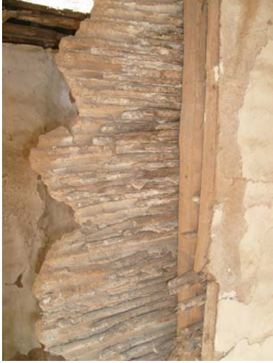
Resim 3.20. Ayçiçeği sapı ile oluşturulmuş bağdadi duvar
