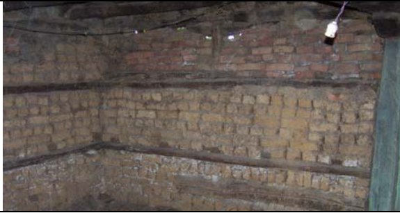
Resim 3. Kerpiç ve tuğla tabakalı duvarın içten görünüşü
