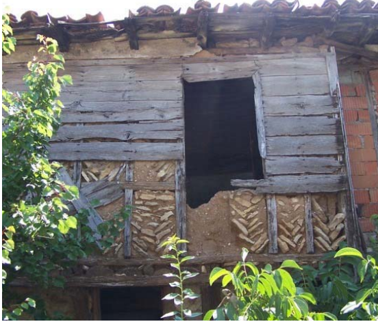
Resim 3.13. Ahşap iskelet arası toprak harçlı taş dolgu
