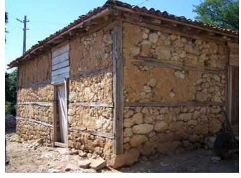
Resim 3.8. Ahşap hatıllı taş duvar örgüsü
