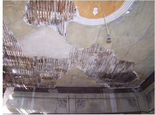
Resim 3.26. Tavan kirişlemelerine alttan çakılan bağdadi çıtaları
