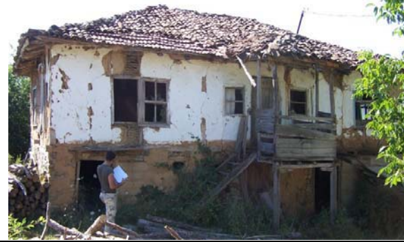
Resim 1. Yapının ön cephesinden bir görüntü
