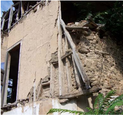
Resim 3.18. Ahşap iskelet arası toprak harçlı kerpiç dolgu
