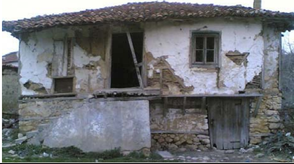
Resim 1. Yapının ön cephesi
