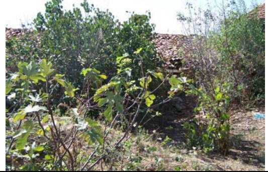
Resim 2. Yapının arka cephesinden görünüşü
