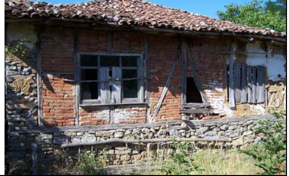
Resim 2. Yapının yan cephesinden bir görüntü
