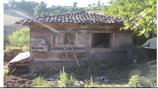
Resim 2. Yapının yan cephesinden bir görünüş
