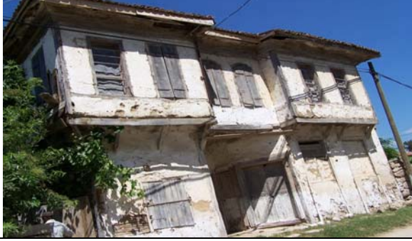
Resim 1. Yapının ön cephesi
