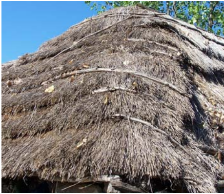
Resim 3.29. Çavdar sapı örtülü çatıdan bir detay
