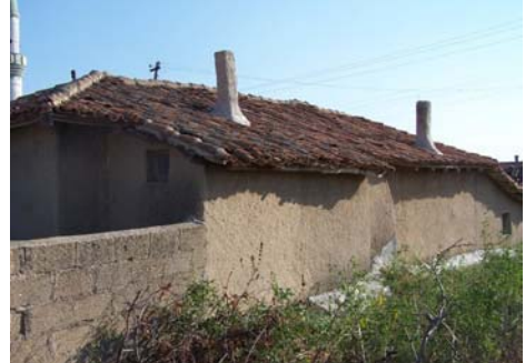
Resim 2. Yapının arka görünüşü
