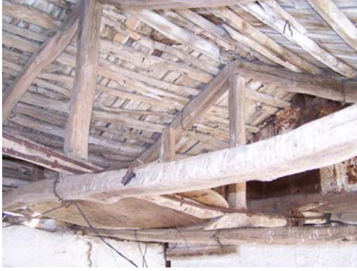
Resim 31. Kiremit altı ahşap kaplama
