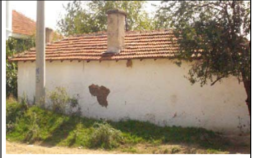
Resim 2. Yapının arka görünüşü
