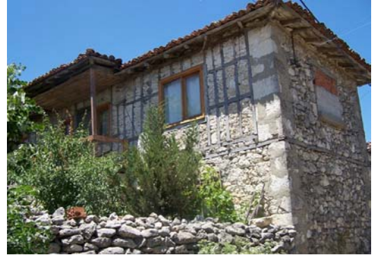
Resim 3.10. Ahşap hatıllı ve kireç harçlı taş duvar örgüsü
