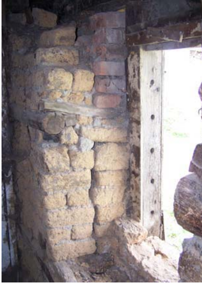
Resim 3.21. Tuğla - kerpiç tabakalı duvar
