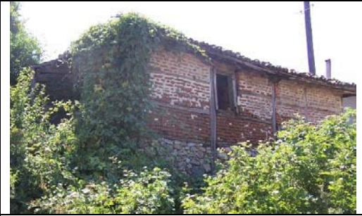
Resim 4. Yapının arka ve yan cephesi
