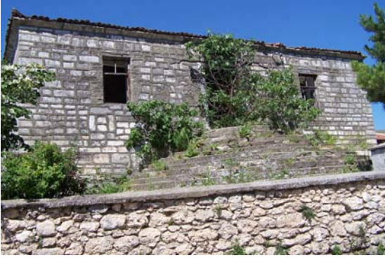
Resim 3.9. Kireç harçlı taş duvar örgüsü
