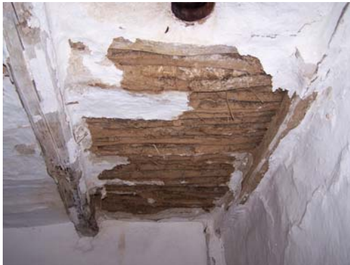
Resim 3.27. Ahşap kirişleme üzeri ağaç dalı tavan döşemesi
