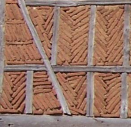
Resim 3.16. Ahşap iskelet arasının toprak harçlı dilim tuğlası ile doldurulması
