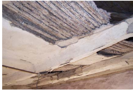
Resim 3.28. Ahşap kirişleme üzeri ayçiçeği sapı tavan döşemesi
