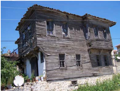
Resim 3.37. Dış cephede ahşap kaplama
