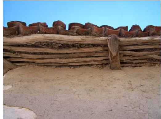
Resim 34. Kiremit altında ağaç dalı üzeri eğrelti otu (papra) kaplama
