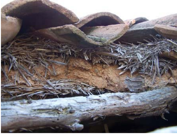
Resim 35. Kiremit altında ağaç dalı üzerinde sırasıyla çavdar sapı, toprak harç kaplama, çavdar sapı kaplama
