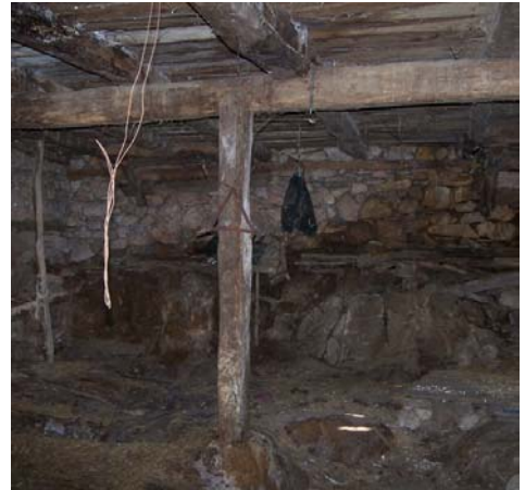
Resim 3.5. Münferit taşlar üzerine oturtulmuş ahşap dikme
