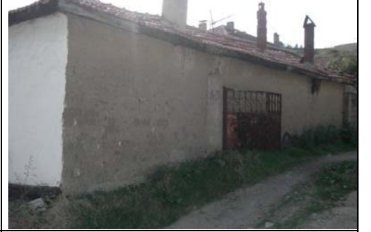
Resim 2. Yapının arka görünüşü
