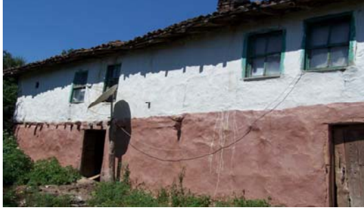
Resim 1. Yapının ön cephe görünüşü
