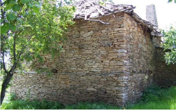
Resim 3.7. Yassı taşlarla yapılmış kuru taş duvar örgüsü
