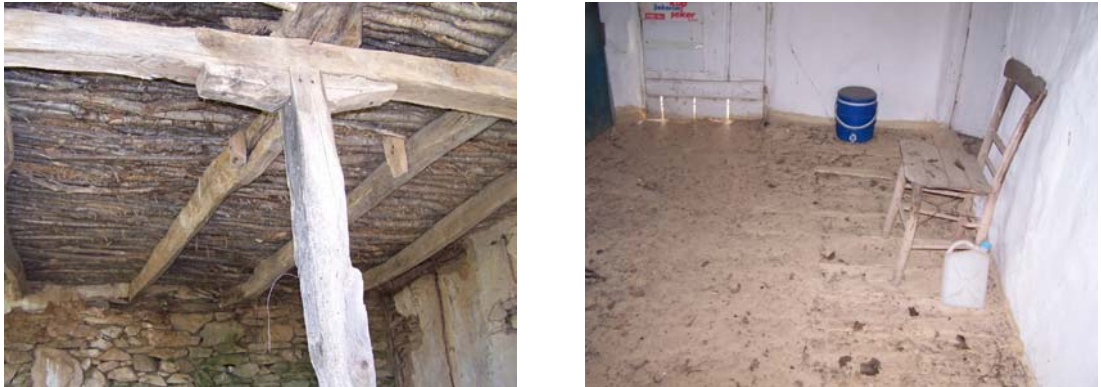
Resim 3.24. Ara kat döşemesinde ağaç dalı, çavdar sapı, toprak harç katmanlarının alttan ve üstten görünüşü
