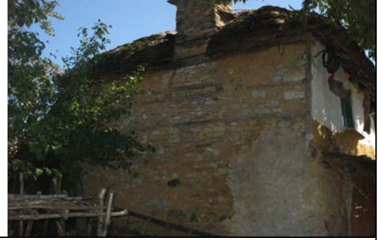
Resim 4. Yapının taş duvarlı kuzey cephesi
