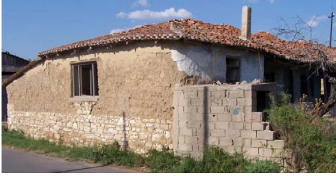
Resim 3.6. Kerpiç yığma duvarda su basman
