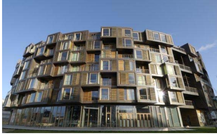
Resim 3.1 Yapının Çevreyle Dokunma Yüzeylerinde Girinti Ve Çıkıntılar (Sasirt.com, 2009)
