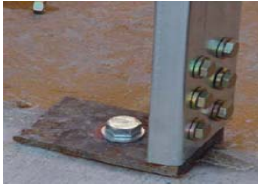
Resim 2.7 Bulonlu Birleştirme (Ekinci, 2006)
