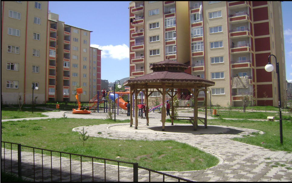
Şekil 5.2. Hasan-i Basri kentsel dönüşüm alanının dönüşüm çalışmalarından sonraki durumu
