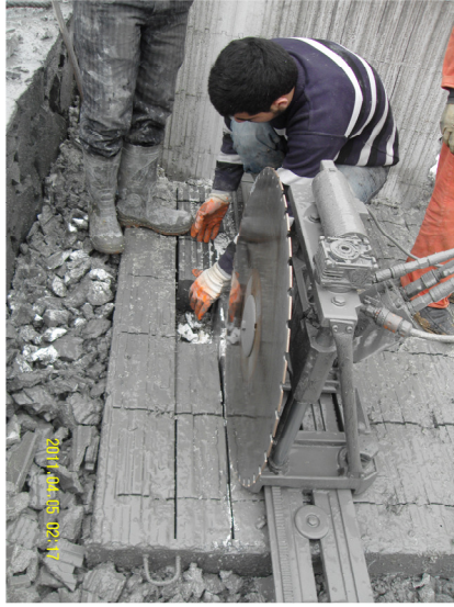
Resim 3.20. Duvar Numunelerinden Kesilerek Beton Numune Alınması
