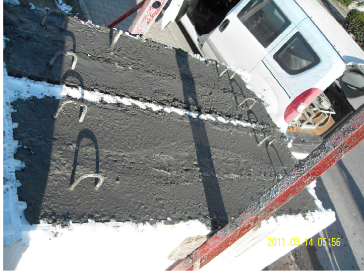
Resim 3.14. Beton Dökümünden Sonra Duvar Numuneleri
