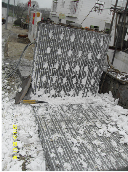
Resim 3.15. Yüzeyindeki EPS Kalıpları Soyulmuş Duvar Numuneleri
