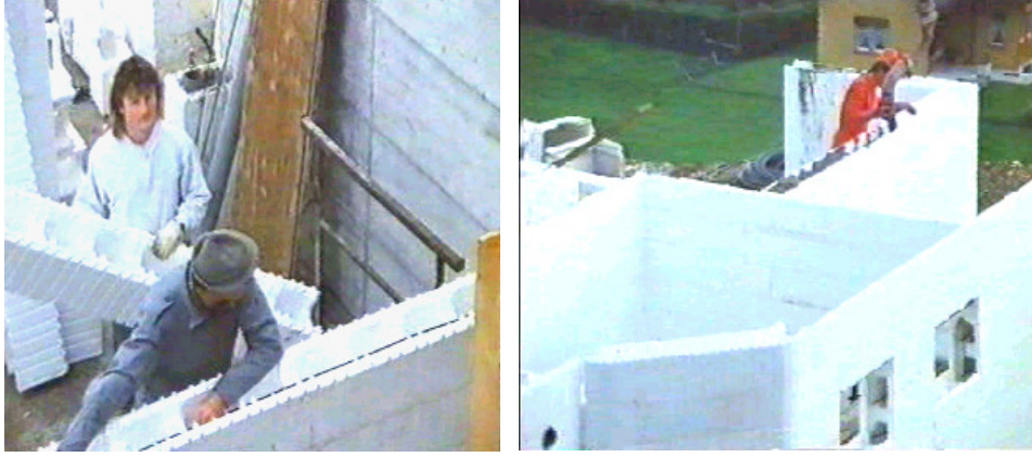
Resim 2.1. EPS YKDBT Duvar Sisteminin Uygulanışı (Web 1)
