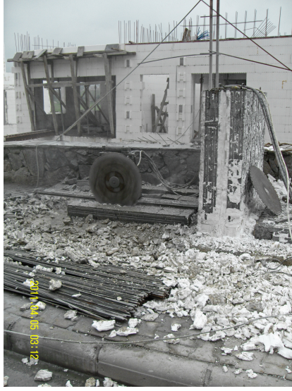
Resim 3.19. Duvar Numunelerin Hidrolik Beton Kesme Makinesi İle Kesilmesi
