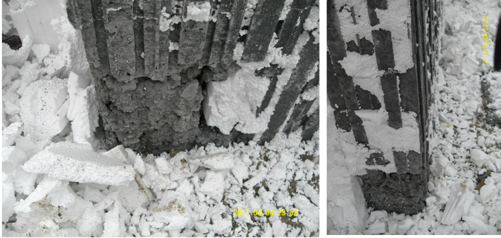
Resim 3.18. EPS Kalıp Söküldükten Sonra Geleneksel Betonda Gözlenen Ayrışma
