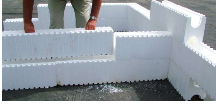
Resim 2.2. EPS YKDBT Duvar Sisteminde Duvarların Oluşturulması (Web 2)
