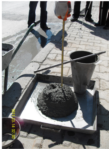
Resim 3.5. Çökme (Slump) Deneyinin Yapılışı (çok akıcı olmayan kıvamda)
