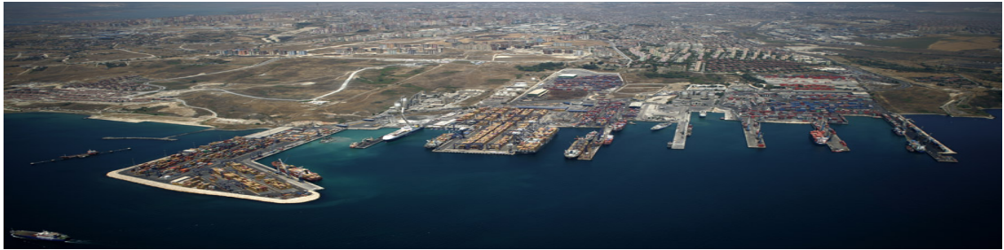
Şekil 1.7. Ambarlı liman tesisleri ( http://www.altasliman.com/terminaller.php )
