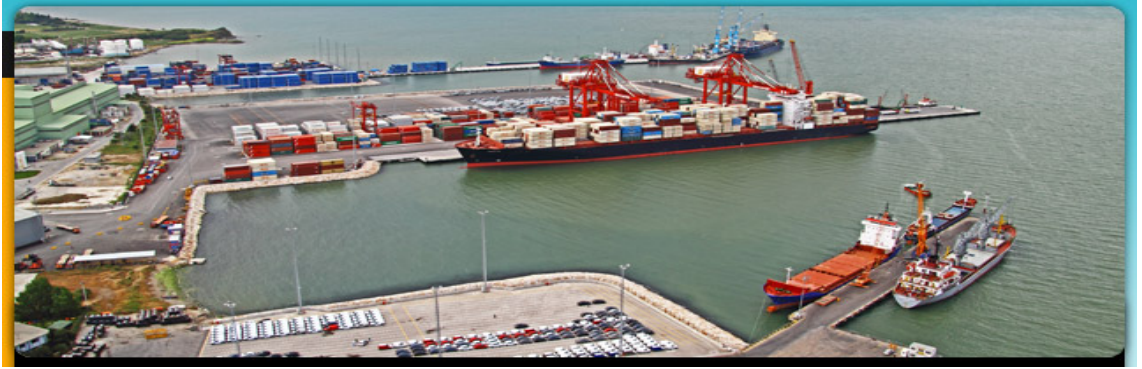
Şekil 1.15. Borusan limanının genel görünümü ( http://www.borusanlimani.com )
