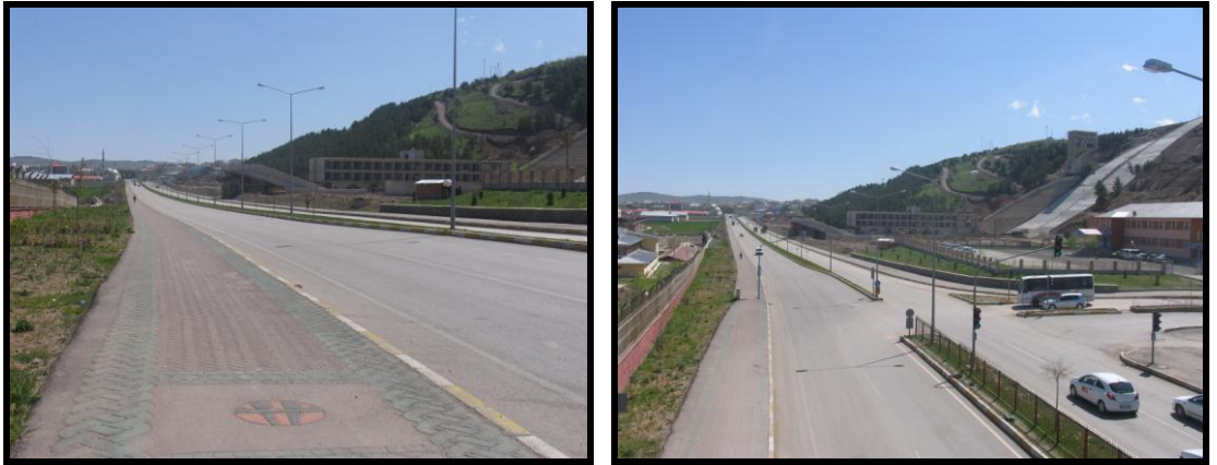
Şekil 3.6. Atlama kuleleri tesisleri ve Atatürk üniversitesine bağlanan cadde
