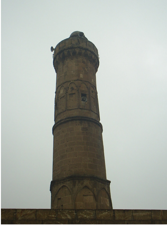
Foto: 41 Pazar Camii Minaresi ve Süs İşlemeleri
