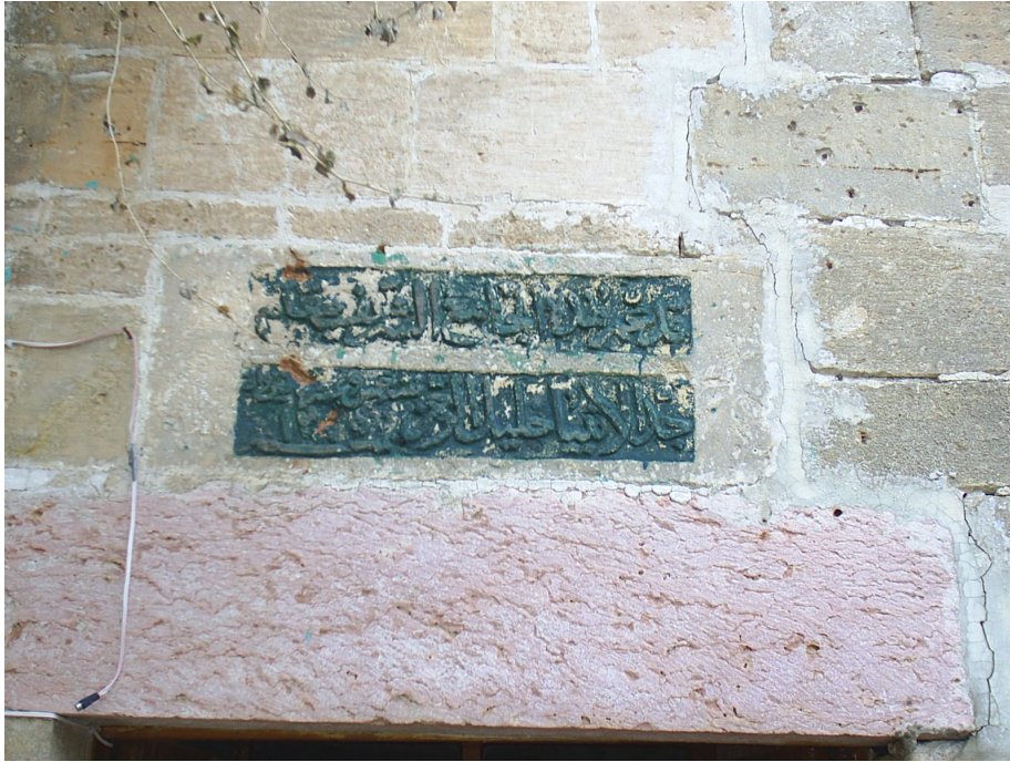
Foto: 32 Halilül Rahman Camii Doğu Kapı Kitabesi
