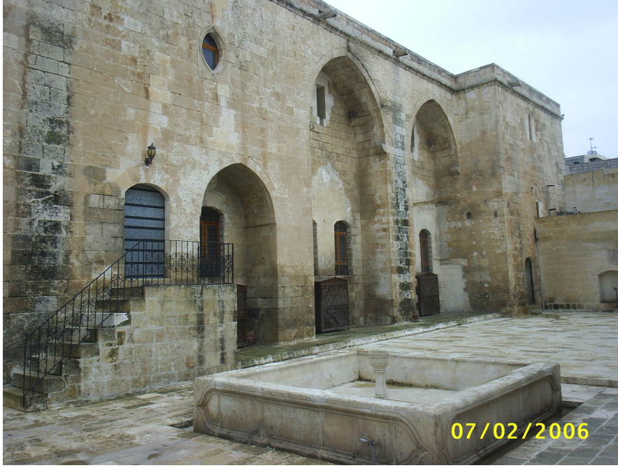
Foto:31 Reji Kilisesi Yan Görünüm
