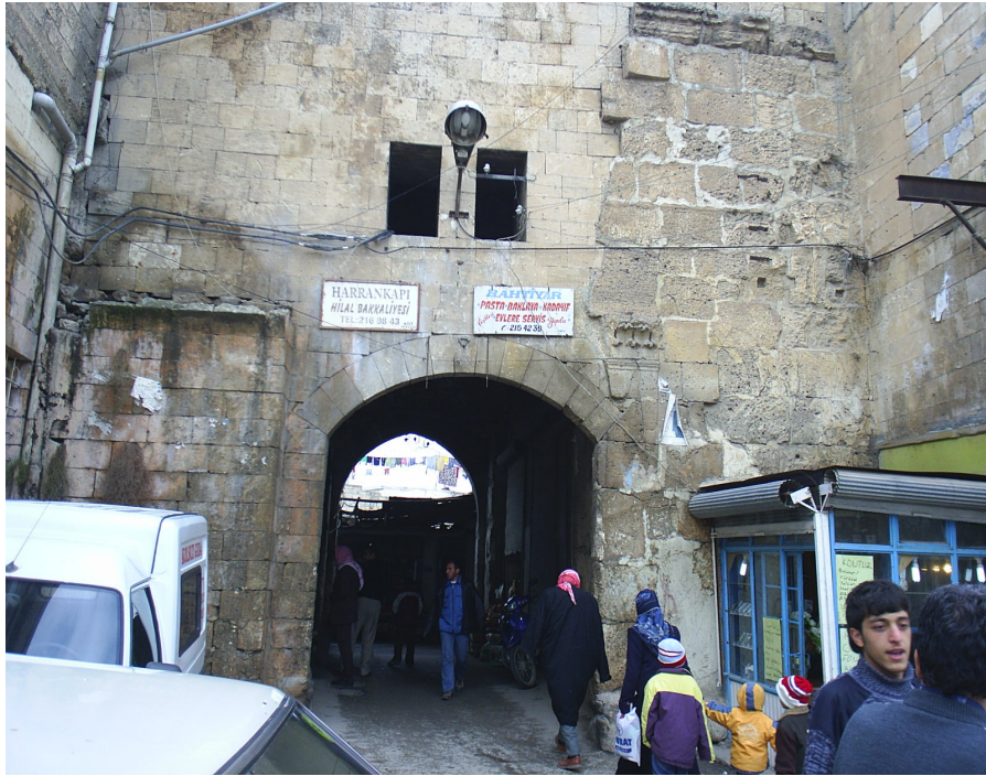
Foto:10 Harran Kapı Kuzey Cephe
