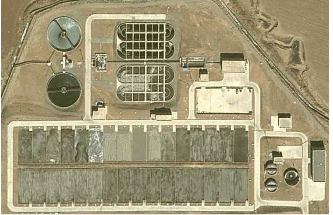
Şekil 4.64. Siirt Belediyesi AAT
