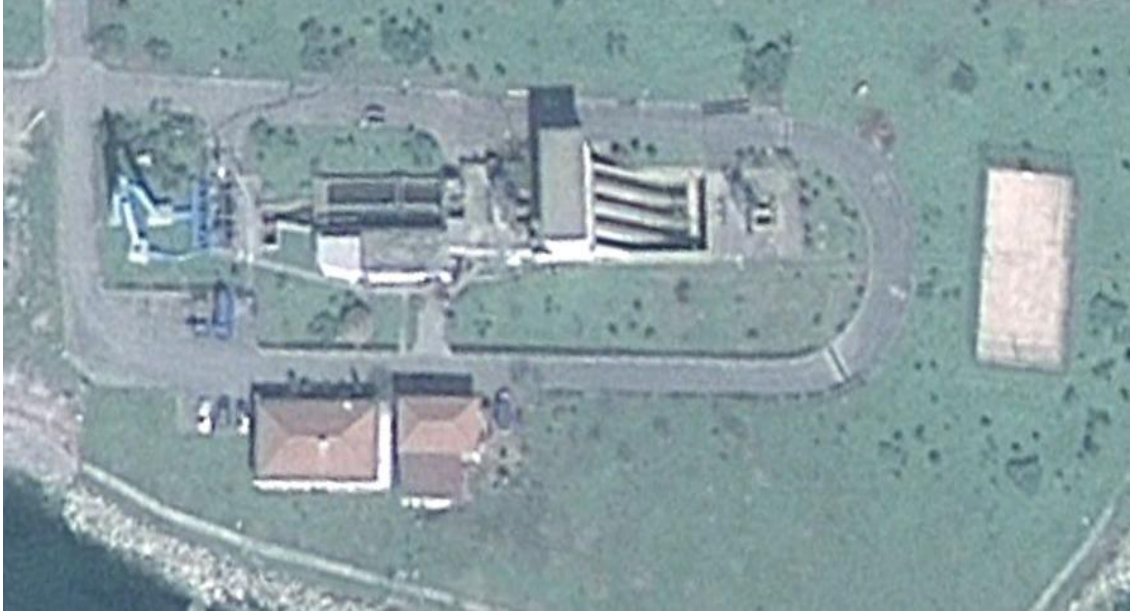
Şekil 4.22. Büyükçekmece ön arıtma ve DDD tesisi
