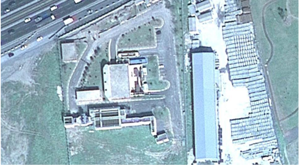
Şekil 4.25. Küçükçekmece ön arıtma ve DDD tesisi
