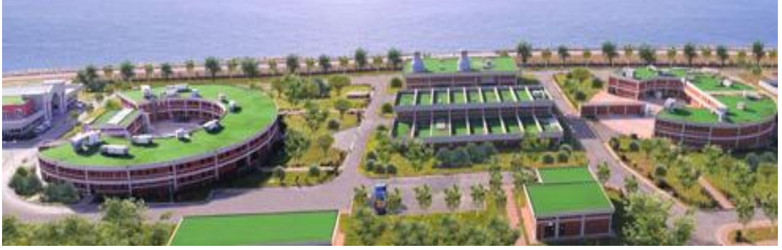
Şekil 4.23. Kadıköy ön arıtma ve DDD tesisi
