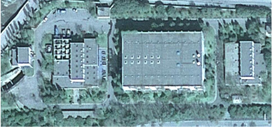
Şekil 4.17. Yenikapı ön arıtma ve DDD tesisi
