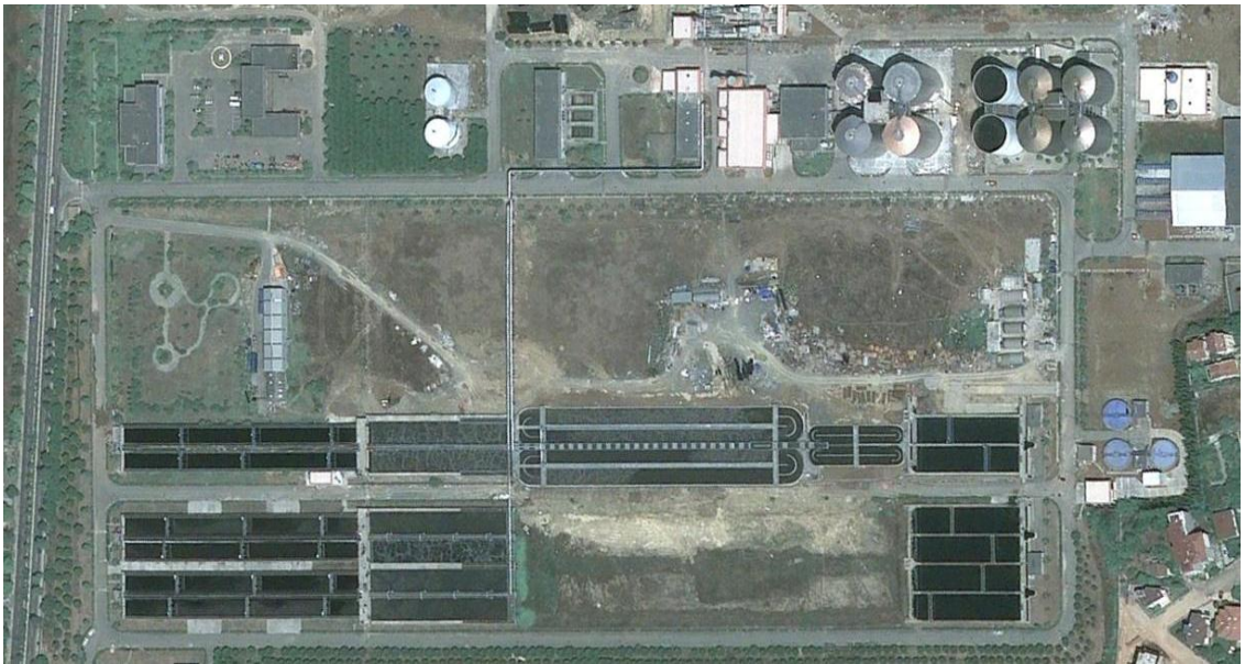
Şekil 4.28. Tuzla atıksu arıtma ve DDD tesisi
