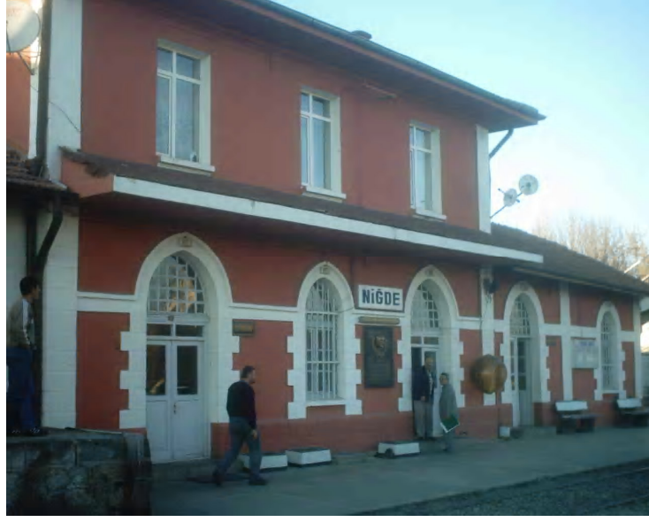
Şekil 4.26. Niğde Demiryolu İstasyonu (foto:2005)
