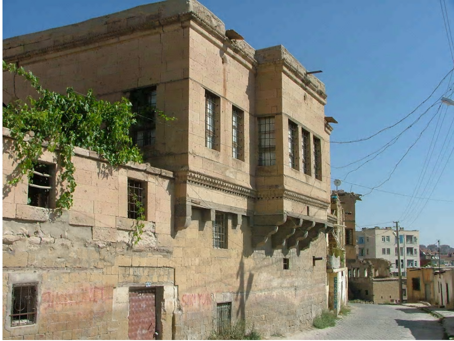
Şekil 4.17. 19. Yüzyılda Yapılan Hastane Binası (foto:2005)
