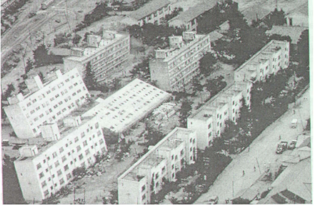
Şekil 2.14. 16 Haziran 1964 Nigata depreminde sıvılaşmadan etkilenen Kawagishi-cho apartmanları [7].
