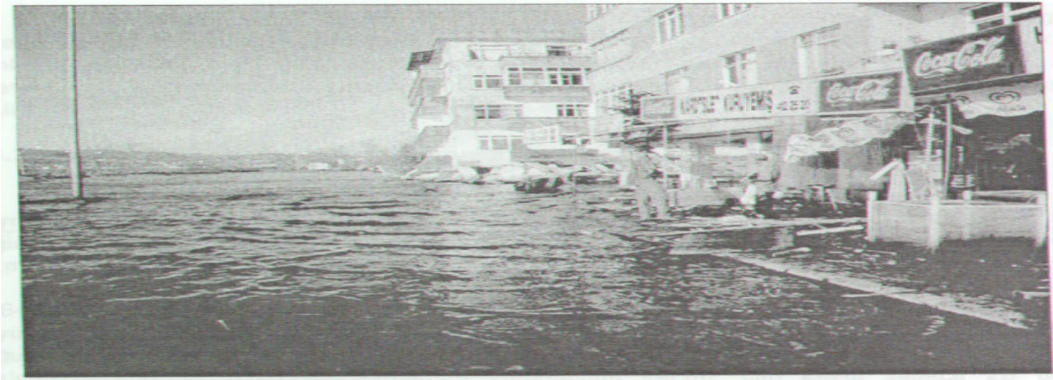
Şekil 2.18. 17 Ağustos 1999 İzmit (Türkiye) depremi sırasında bölgesel çökmeden dolayı meydana gelen su basması [7].
