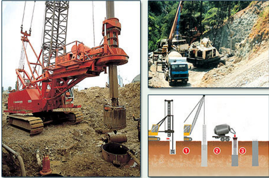
Şekil 2.2 .Fore Kazık Yapım Aşamaları.
