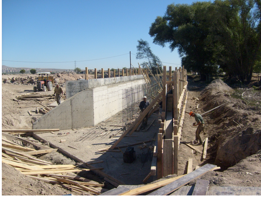
Şekil 5.7. Km 1+400 Menfez İnşaataı.
