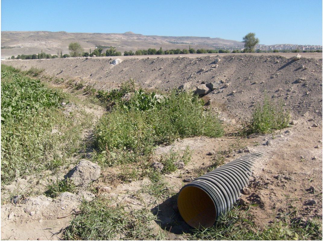
Şekil 5.8. Yatay Drenaj Borusu Teşkili.
