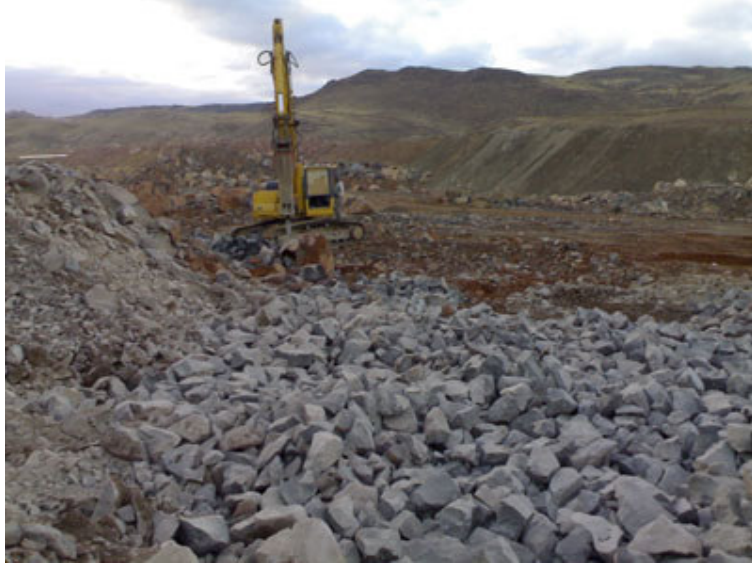
Şekil 2.4. Kaya Dolgu Yapılması.
