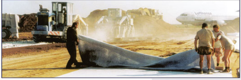
Şekil 4.3. Yol Yapımında Geotekstil Kullanımı.
