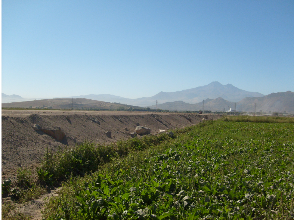
Şekil 5.5. Yolun Şev Kenarından Görünümü.
