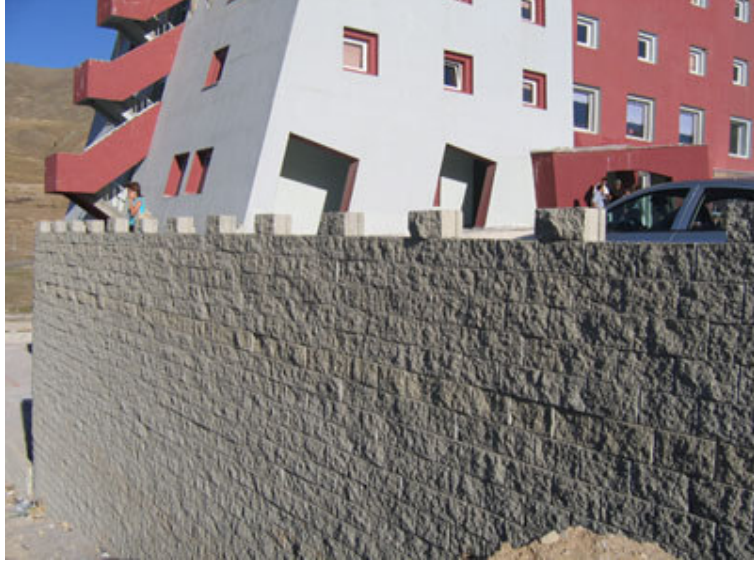
Şekil 4.12. Geoduvvar Uygulaması (Erciyes Dağı Erciyes Üniv. Sosyal Tesisleri / Kayseri ).
