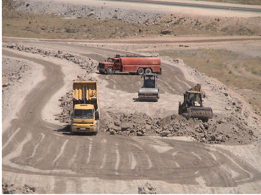
Şekil 5.15. Aydınlar mevkiî Yol Yapım İşi Dolgu Çalışması.
