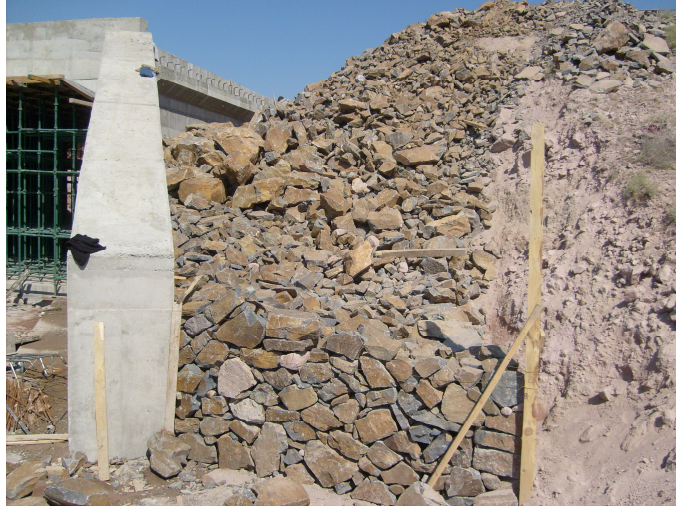
Şekil 2.1. Köprü yan dolgusu ( İstifli Taş Dolgu ).
