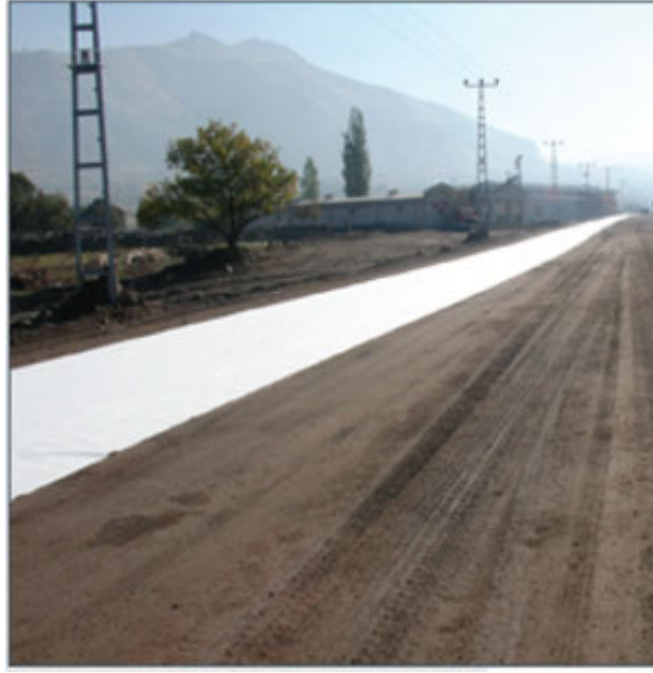
Şekil 4.4. Stabilizasyon Amaçlı Geotekstil Kullanımı.
