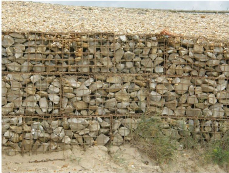
Şekil 2.13. Gabion Kullanılarak Duvar Yapımı.
