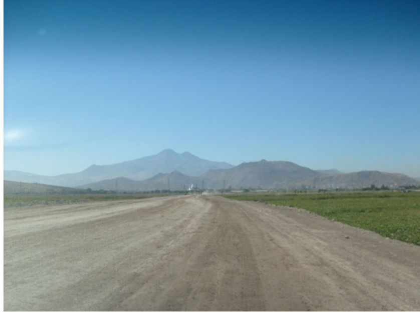
Şekil 5.4. Kaba Malzeme Üzerine İnce Malzeme Serimi.
