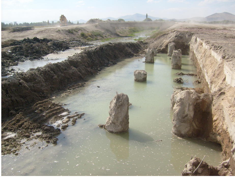
Şekil 5.9. Kanal Köprüsü Fore Kazık Temel Uygulaması.
