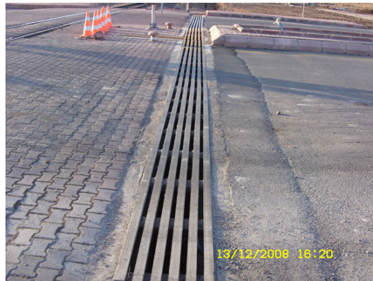
Şekil 3.41. Yolda Enine Doğrultuda Izgara Örneği.
