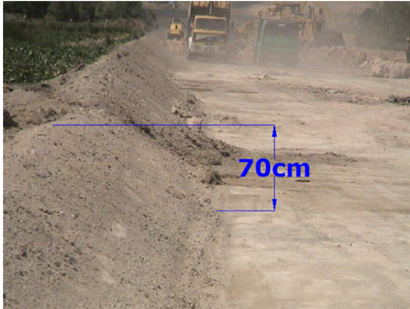
Şekil 5.1. Bitkisel Toprağın Kazılması.
