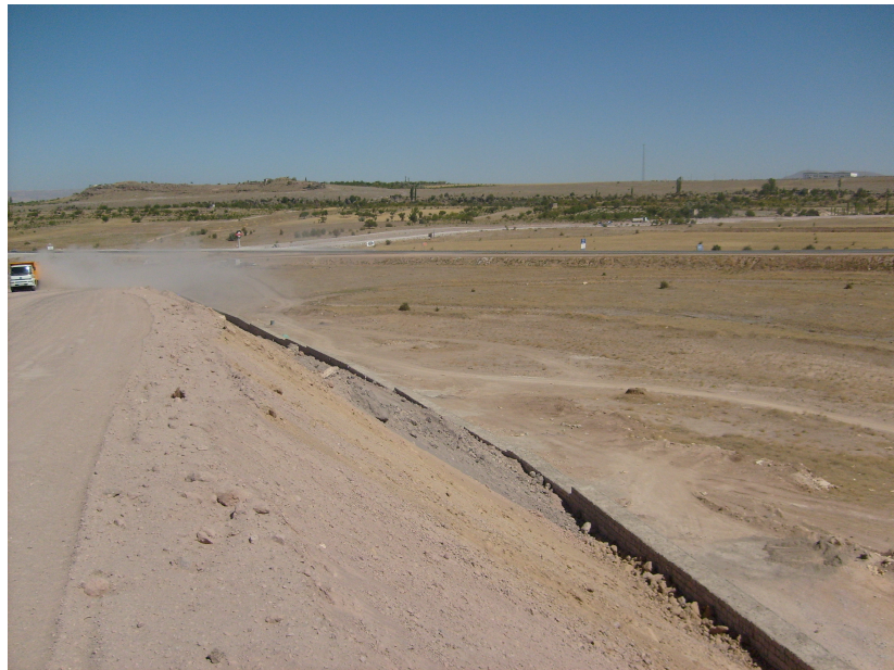
Şekil 5.16. Dolgu Şevi Eteğinde İstinat Duvarı Teşkilî.
