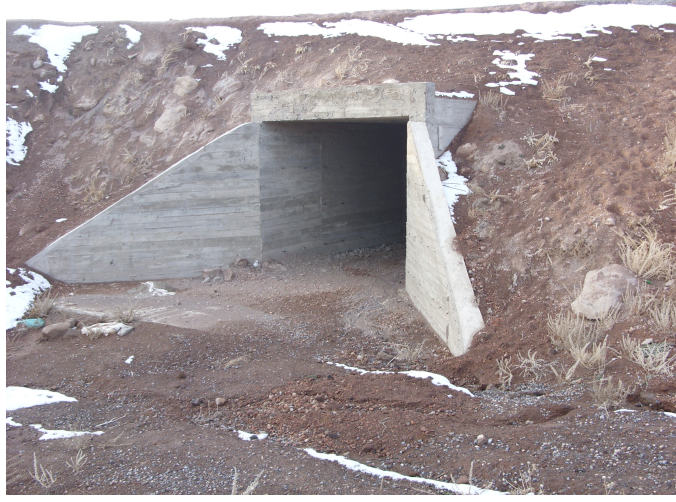
Şekil 5.17. Aydınlar Mevkii Yol Yapım İşi Dahilinde Yaptırılan 3x3 Kutu Menfez.
