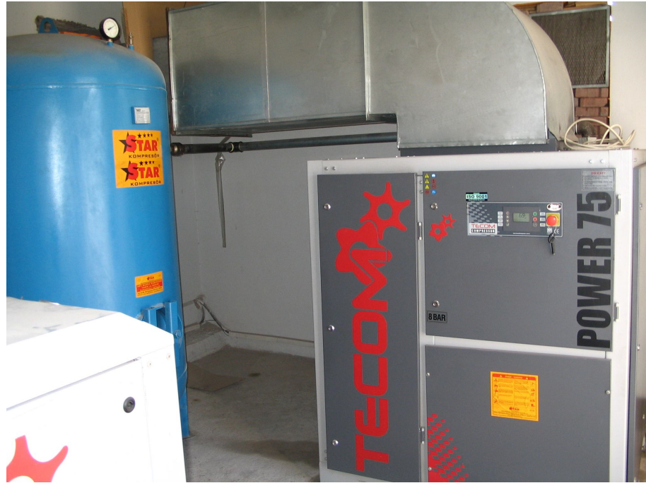
Şekil 3.6. Fabrikadaki kompresörler.
