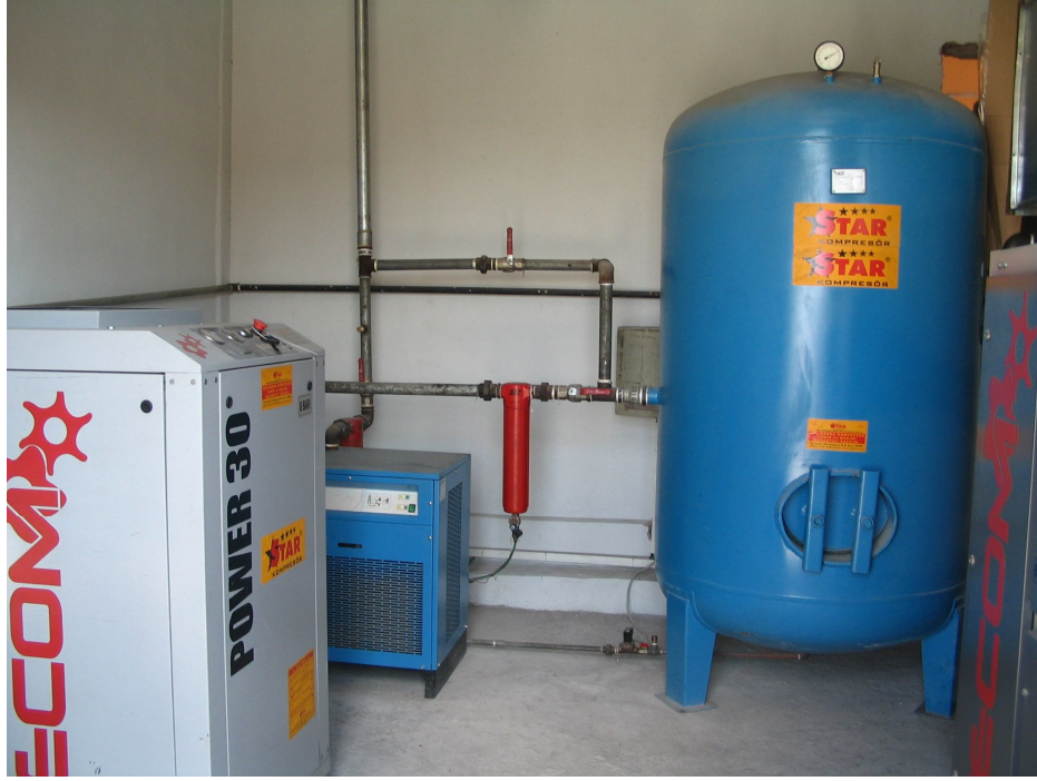
Şekil 3.7. Fabrikadaki kompresörler ve kurutucu.
