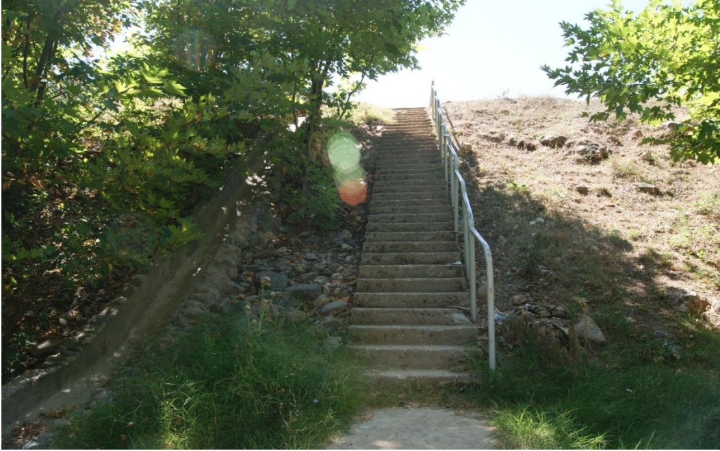
Şekil 4.22. Hisarbey Göletinde Göl Kenarına Ulaşılmakta Kullanılan Beton Merdiven (Özgün 2010)
