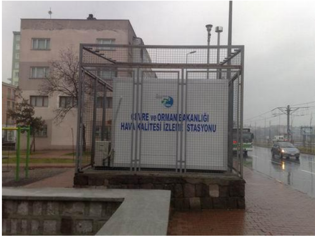
Şekil 2.3. Hürriyet Mahallesi SO 2 , PM, NO x , CO emisyon ölçüm istasyonu [48]
