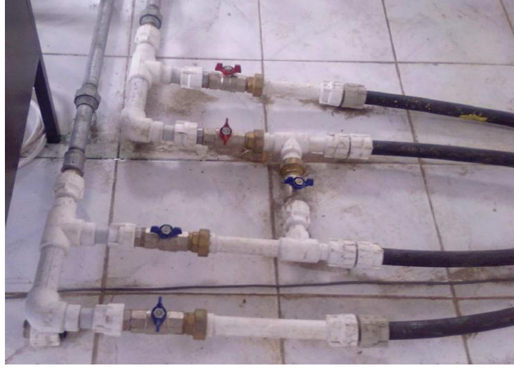
řekil 3.3. Toprak ısı deęiřtircisinin paralel ve seri baęlantısının montaj resmi
