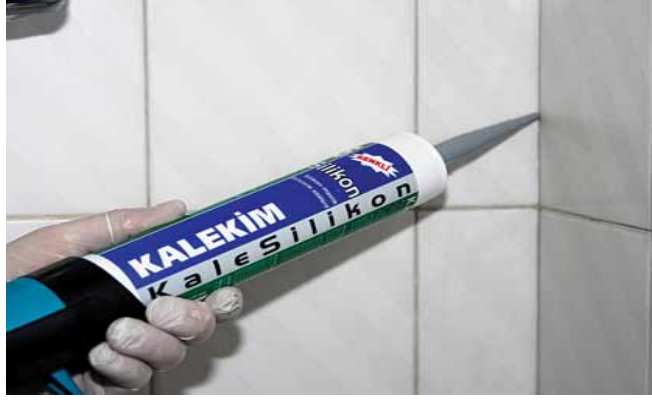
Şekil 2.3. Silikon mastiğin yalıtım malzemesi olarak kullanımına ait görüntü.
