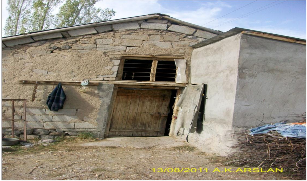
Şekil 4.8. Bir işletmeye ait dış cephe görünüşü
