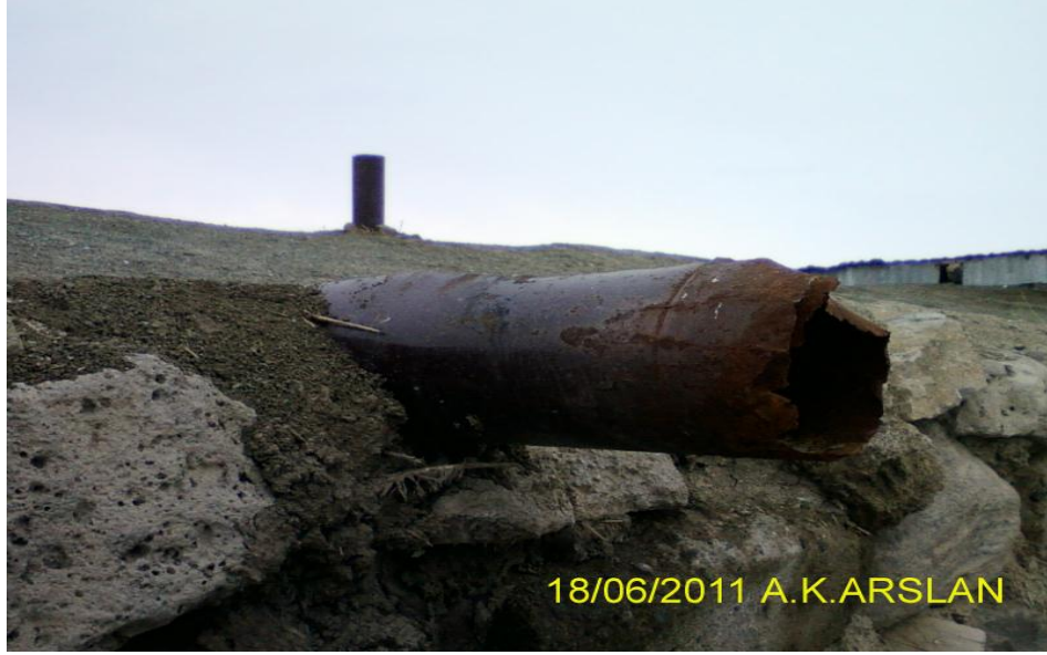
Şekil 4.9. İşletmenin birine ait çatı görünümü
