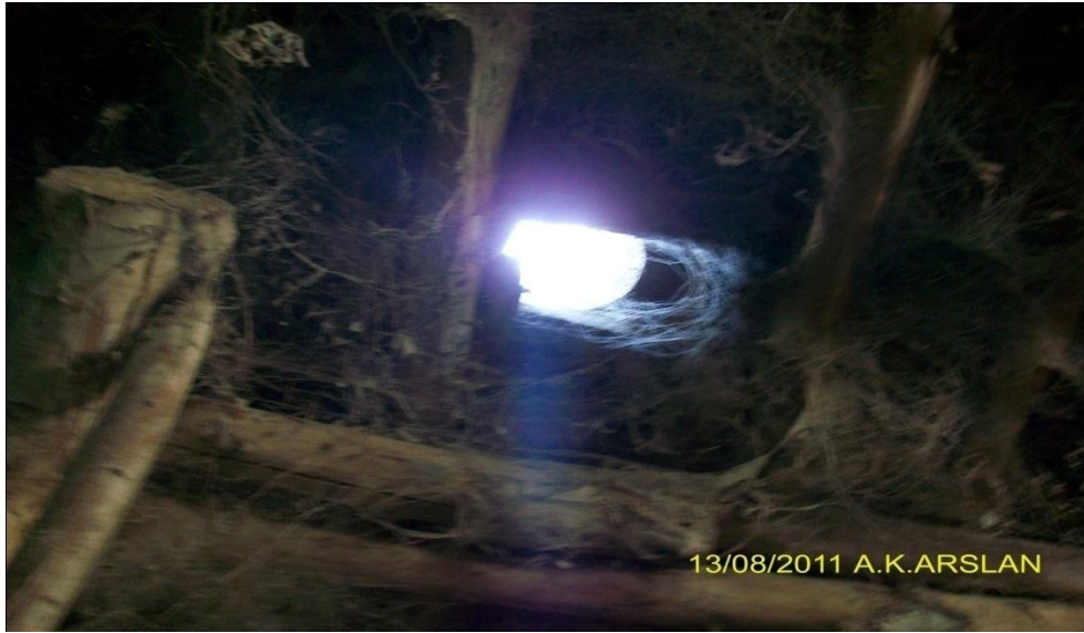
Şekil 4.15. Bir ahırda daire kesitli hava çıkış bacası
