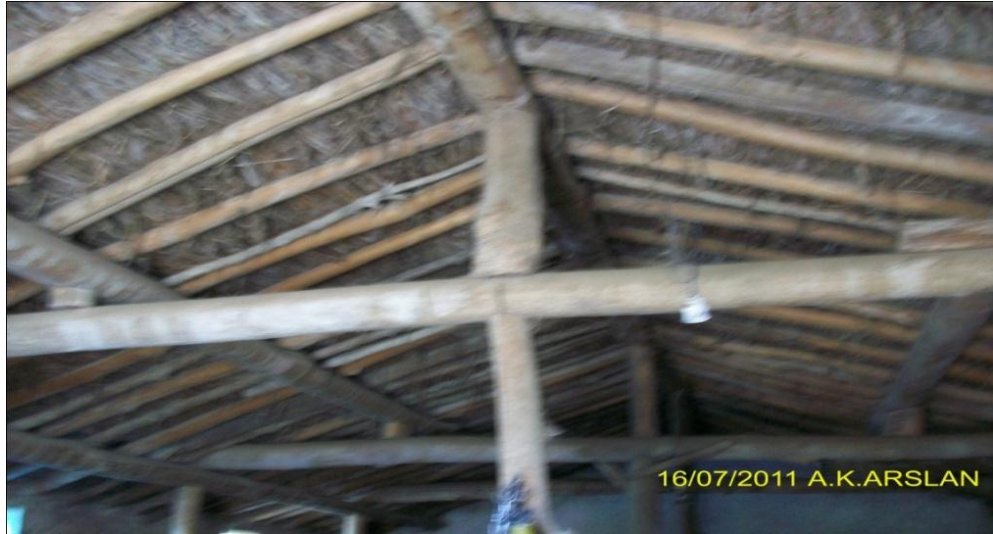
Şekil 4.10. Bir işletmenin kavak ağacından yapılmış ahşap çatı makası
