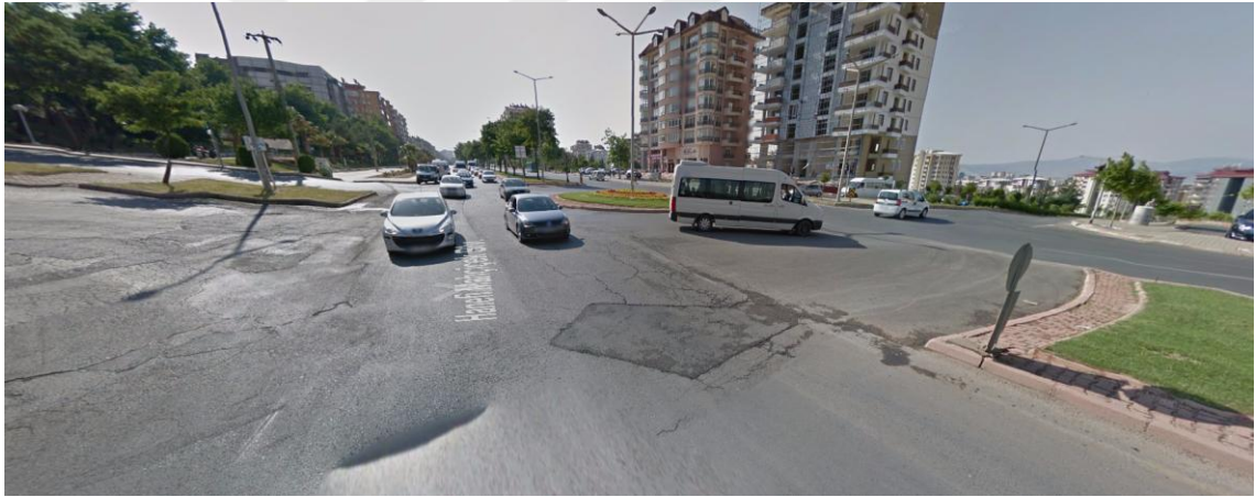
Şekil 3.34 Yeşil Evler Kavşağı Görünümü [45].
