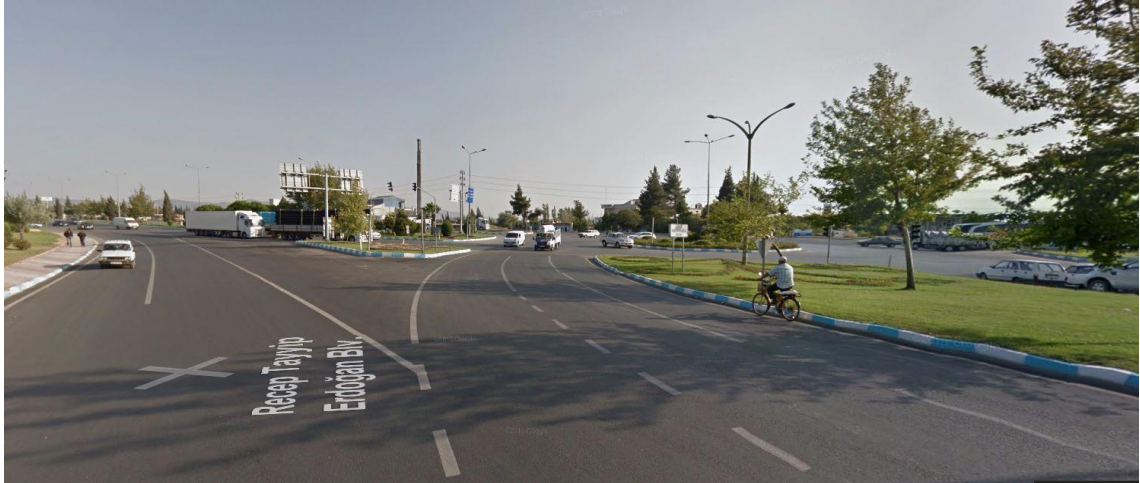
Şekil 3.16 Gaziantep Yolu Sanayi Kavşağı Görünümü [45].
