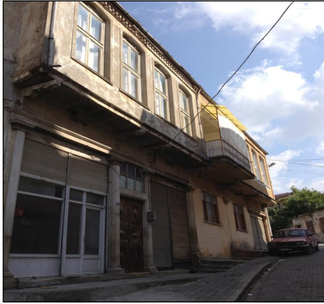
Şekil 91. İstiklal Sokak üzerinde işlevlendirilmiş bir yapının cephe değişimi [134].
