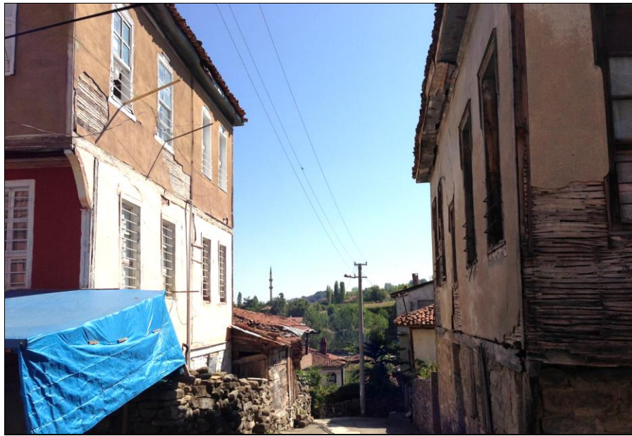
Şekil 77. Çay Sokakta geleneksel bir duvar örneği [134].
