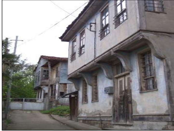
Şekil 93. İstiklal Sokak üzerinde çıkma sokak örneği (Çeşme 1. Sokak) [134].
