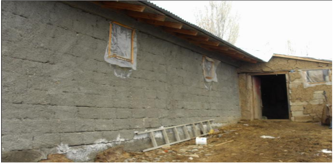
Şekil 4.2. Duvarları briketten yapılmış bir ahırın dış görünüşü
