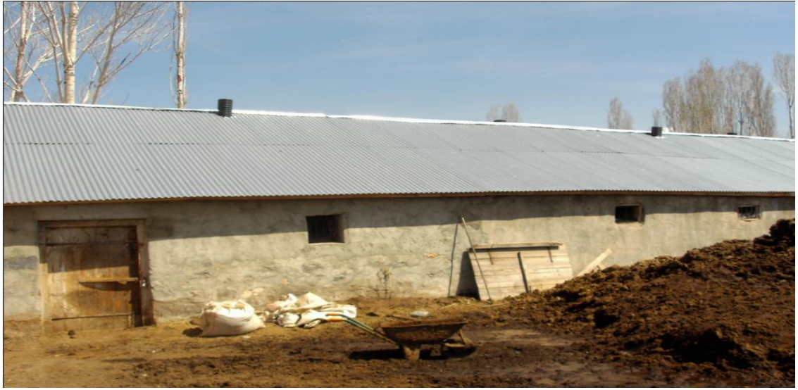
Şekil 4.5. Ahır uzun duvarına yerleştirilmiş bir ahşap kapı
