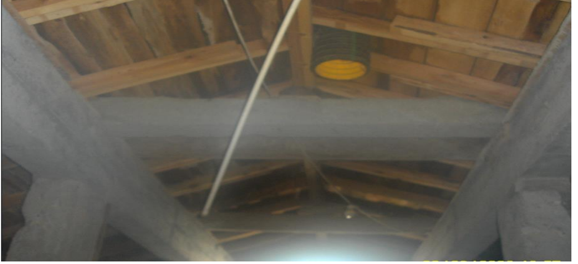
Şekil 4.3. Çatı makasının ahır içerisinden görünüşü
