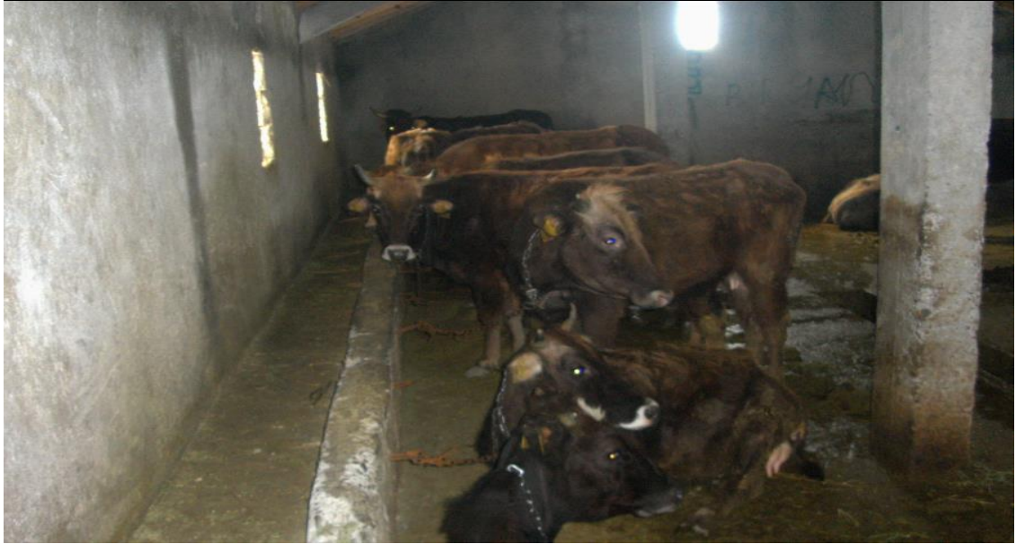
Şekil 4.1. Uzun duvara bitişik, briketten havuz şeklinde yemlikler
