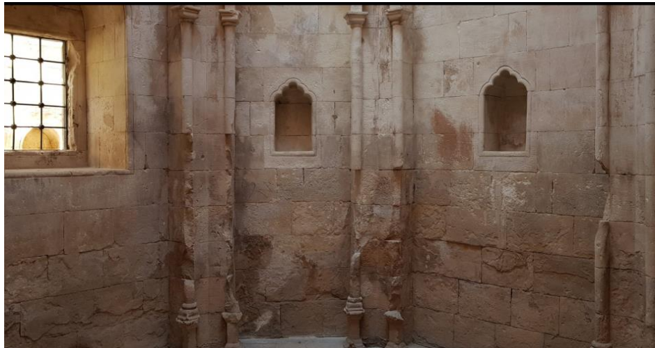
Şekil 1.6. İshak Paşa sarayındametal ve taş borular [20-22]
