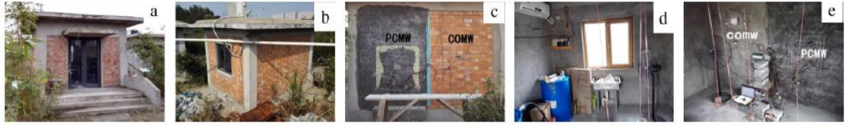
Şekil.1.26. FDM'li tuğla ile yapılmış test odası [39].
