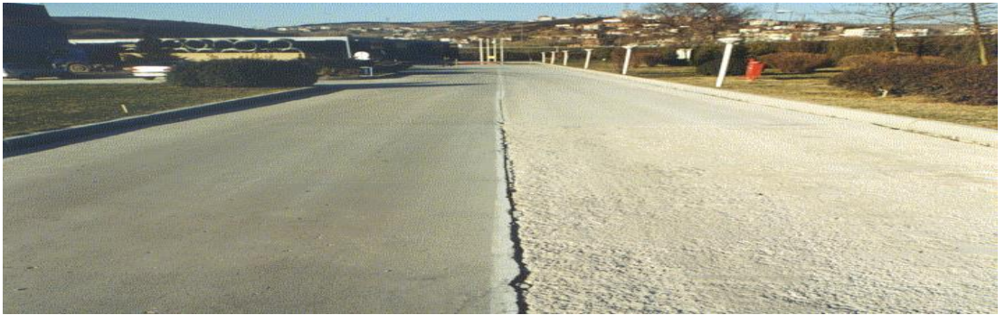
Şekil 2.11. 15 yıl önce aynı zamanda yapılan çelik tel donatılı ve donatısız beton yol
