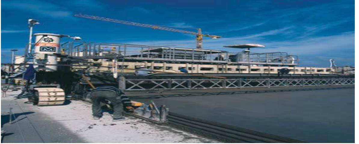
Şekil 2.3. Esnek üstyapı çalışması
