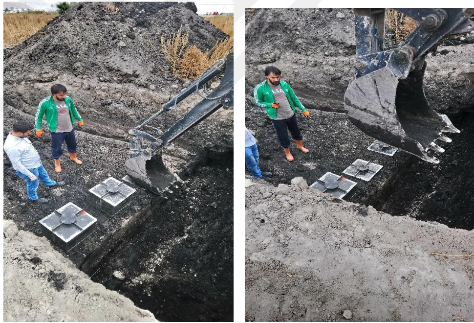
Şekil 3.8. Numune kasalarının organik zemin içerisine gömülmesi işlemi
