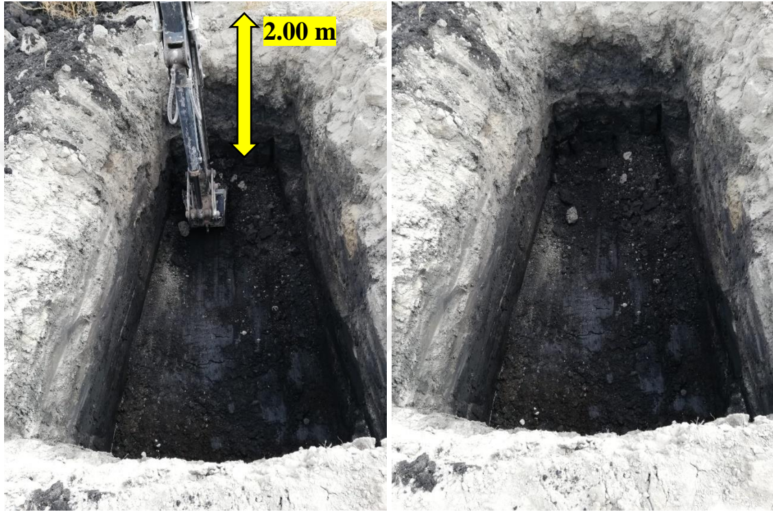
Şekil 3.4. Araştırma Çukuru (AÇ-1) kazı çalışması ve nihai görünümü
