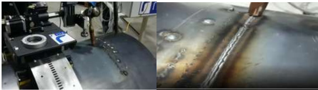
Şekil 42 - Kaynağa başlamadan önceki duruş ve boruya yapıla test kaynağı
