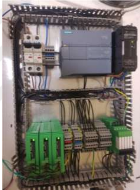
Şekil 35 - Kontrol ünitesi tasarımı ve kablolaması
