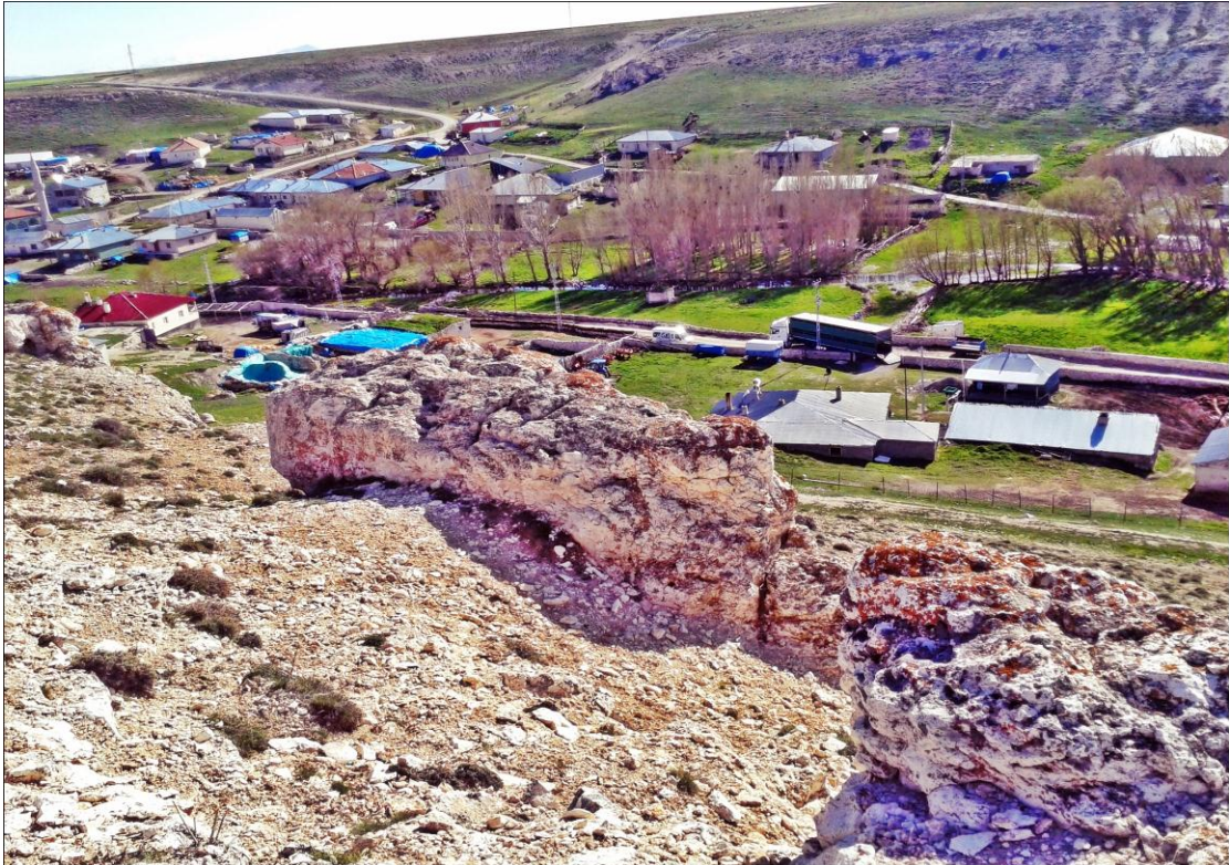
Şekil 4.3. Pınarbaşı İlçesi Kurbağalık Mahallesi Kaya Düşmesi Olayı[43]
