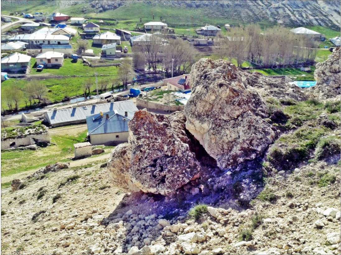
Şekil 4.2. Pınarbaşı İlçesi Kurbağalık Mahallesi Kaya Düşmesi Olayı[43]
