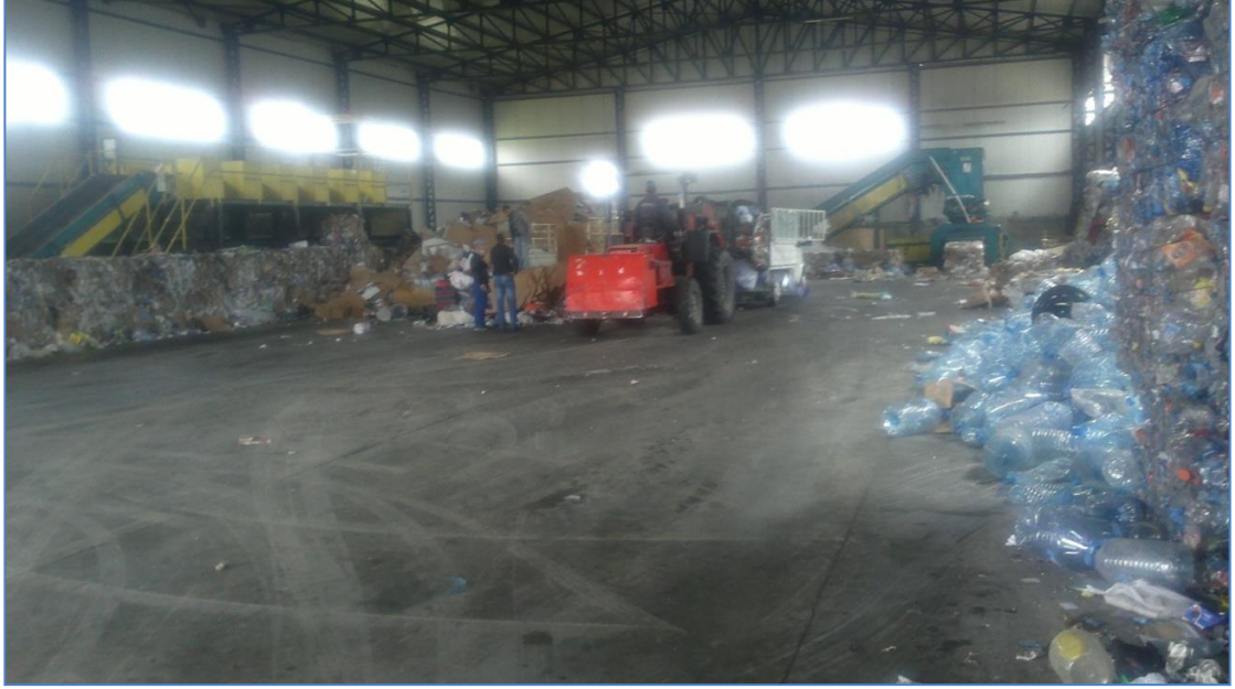
Şekil 2.5. Toplama ayırma tesisi 2
