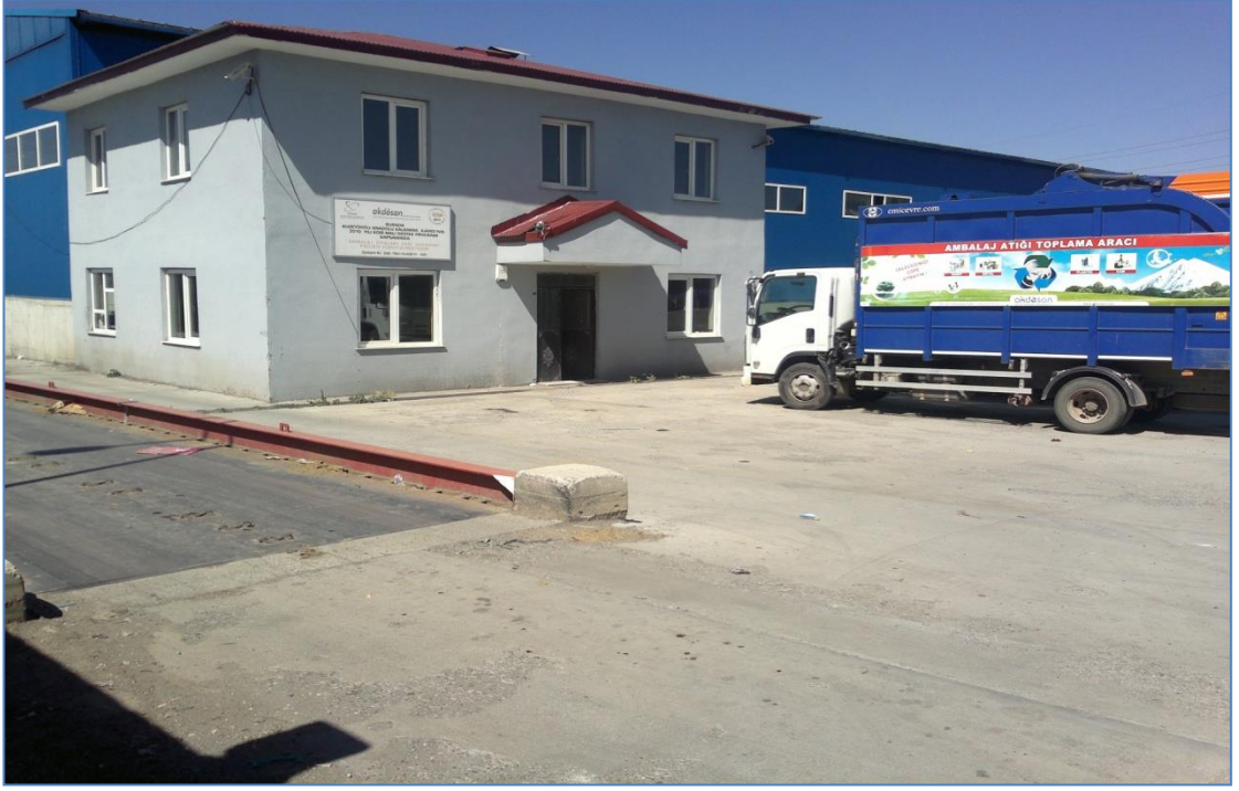
Şekil 3.2. Toplama ayırma tesisi (AKDÖSAN)
