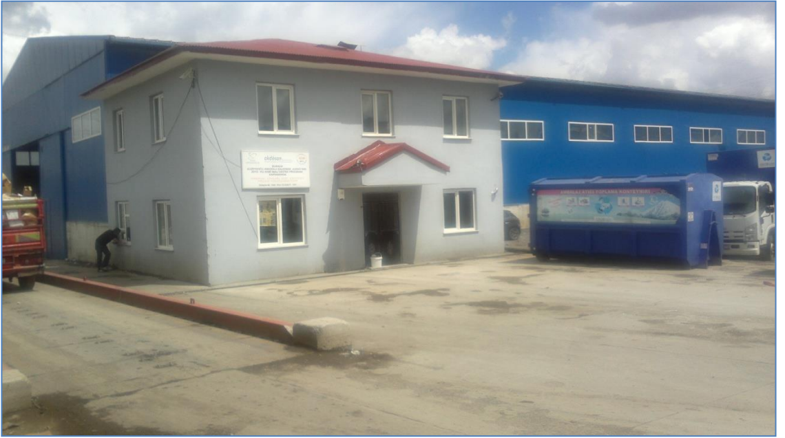
Şekil 2.4. Toplama ayırma tesisi 1
