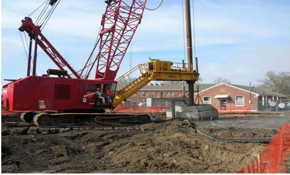
Şekil 2.11. Derin kuru karıştırma (Day et al. 2005)
