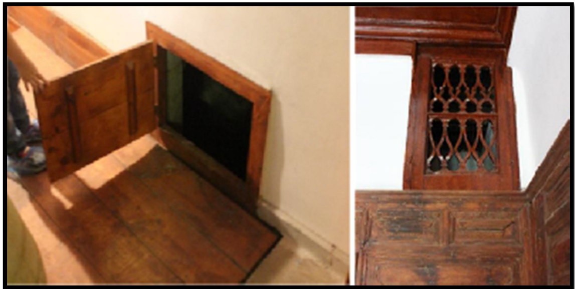
řekil 1.8. Geleneksel Kayseri Evlerinde Odalar Arası Havalandırma [43]
