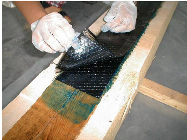
Şekil 1.8. Ahşap kiriş üzerine fiber takviye uygulanması [47]
