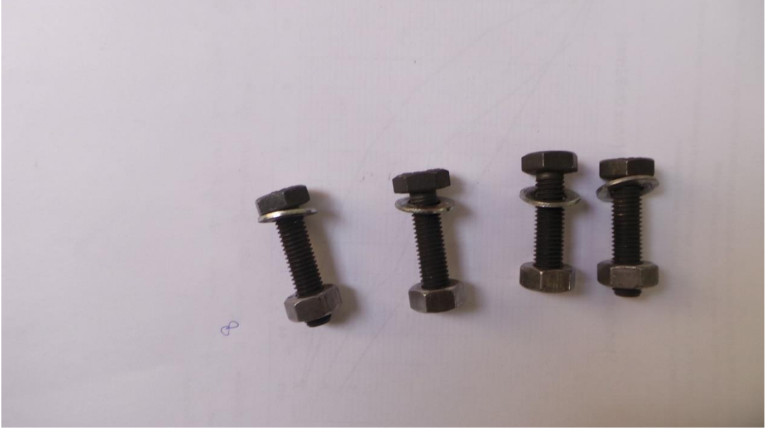
Şekil 4.62. Birleşimin üst bölgesinde meydana gelen cıvata kırılmaları
