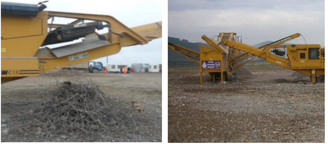
Şekil 2.5. Malzemelerin ayrılması ve eleğe gönderilmesi
