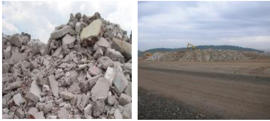
Şekil 2.3. İnşaat yıkıntı atıklarının tesise kabul edilmesi
