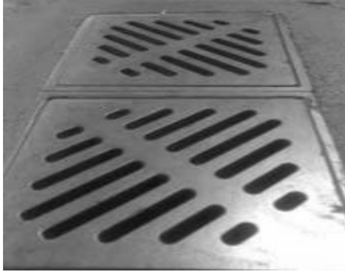
Şekil 1.10. RPB kullanılarak yapılan yağmur suyu ızgaraları (İpek 2009)
