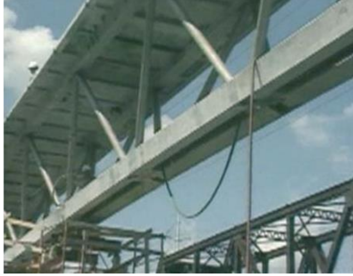
Şekil 1.6. RPB kullanılarak üretilen Sherbrooke Köprüsü (Gilliand 1996)
