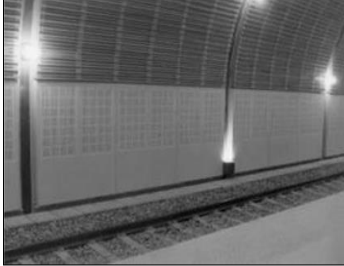
Şekil 1.9. RPB kullanılarak yapılan ses bariyeri (İpek 2009)
