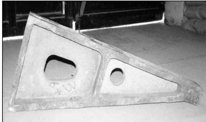
Şekil 1.7. RPB kullanılarak yapılan yaya kaldırım elemanı (Wen-Yu et al. 2007)
